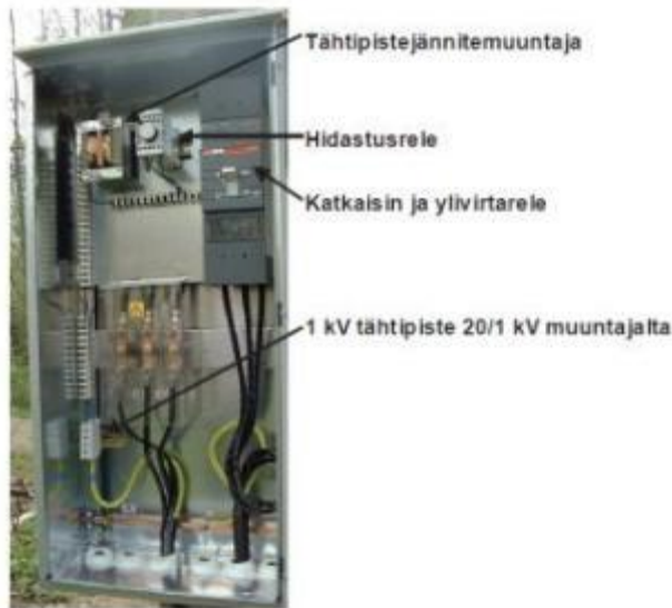
Kuva 47. 1000 V verkkojen suojauksessa käytettävä suojalaite ja sen osat. (Partanen ym. 2005,15)
