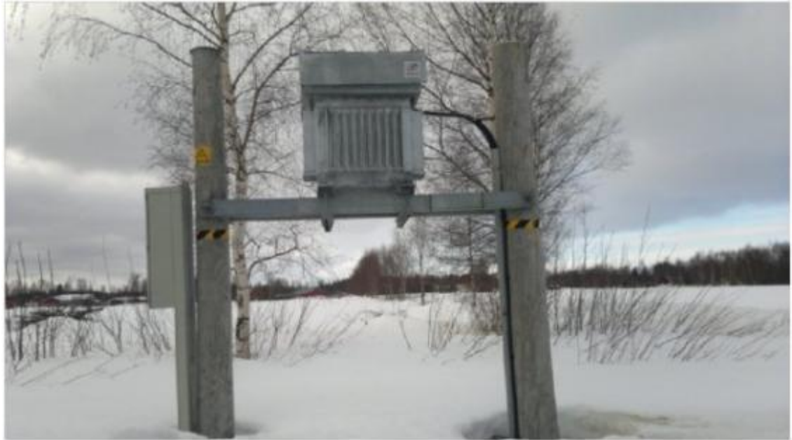
Kuva 77. HSO:n käytössä olevasta jänniteboosterista
