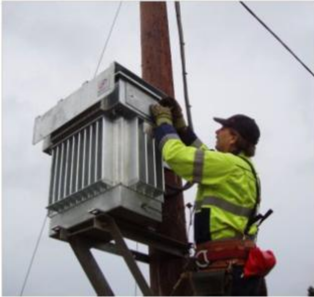
Kuva 81. Pylväsasennus (Tjeldholm, 2012,26)
