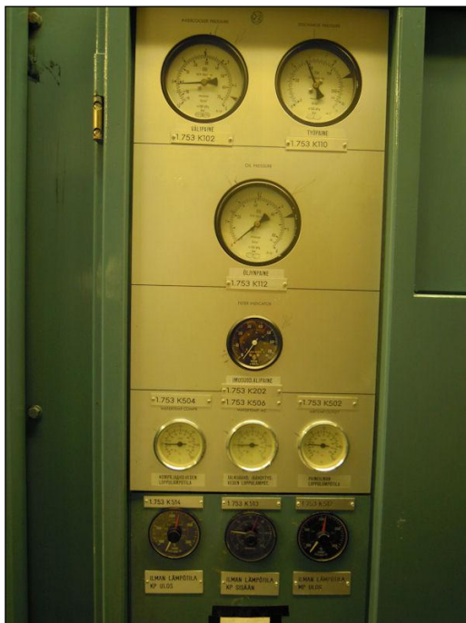
Kuva 4. Kompressoriyksikön säätö- ja mittaritaulu
