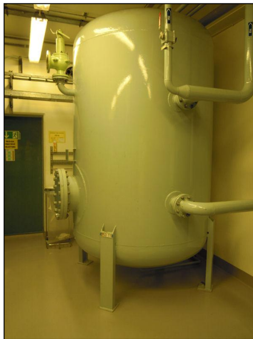
Kuva 9. Paineilman varastosäiliö 1.753T1
