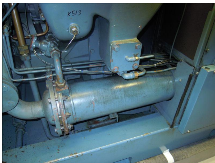
Kuva 6. Jälkijäähdytin kompressoriyksikössä 1.753E1
