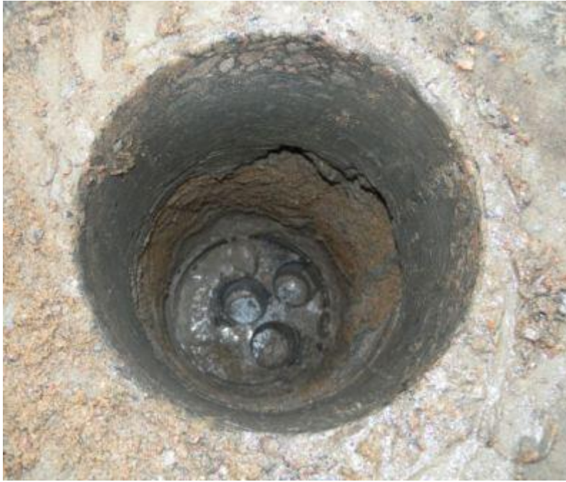
KUVA 8. Kannen pintarakenteiden avaus
