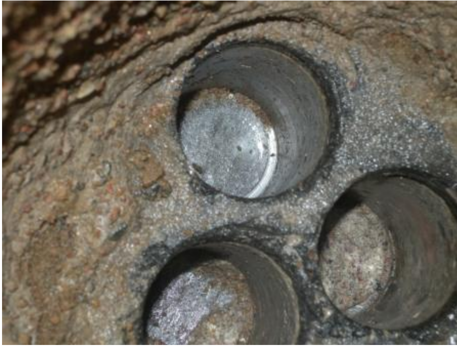
KUVA 23. Teräspalkin ylälaippa avauksen kohdalta
