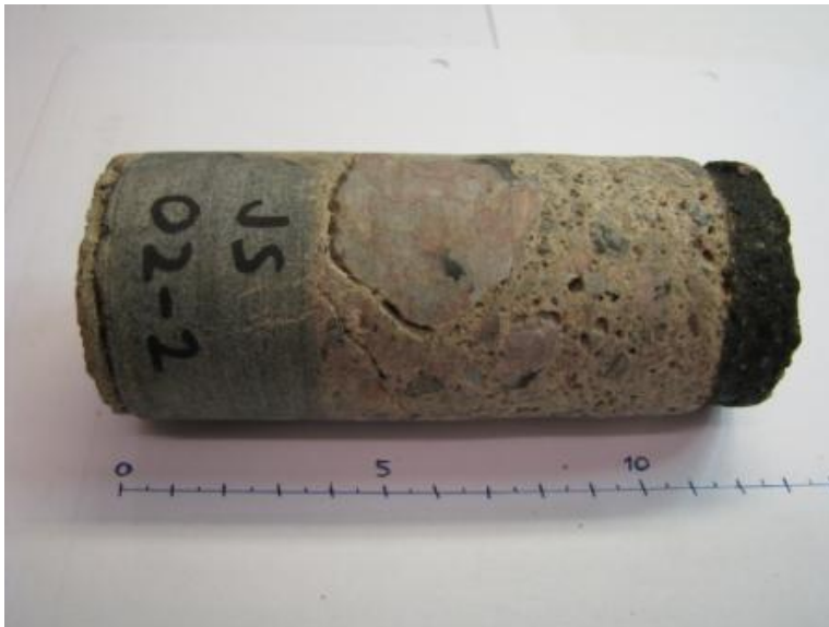
KUVA 13. Lieriönäyte kannen yläpinnan betonista
