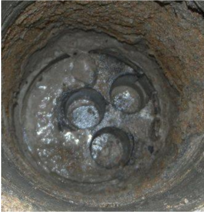
KUVA 33. Suojabetoni ja vedeneriste avauskohdassa
