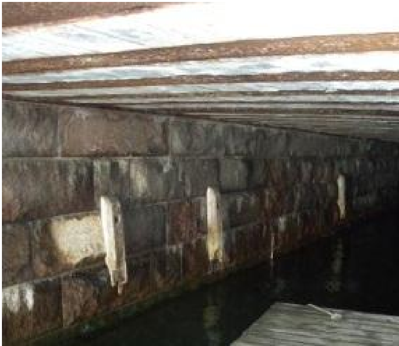
KUVA 28. Välituki, pohjoinen puoli
