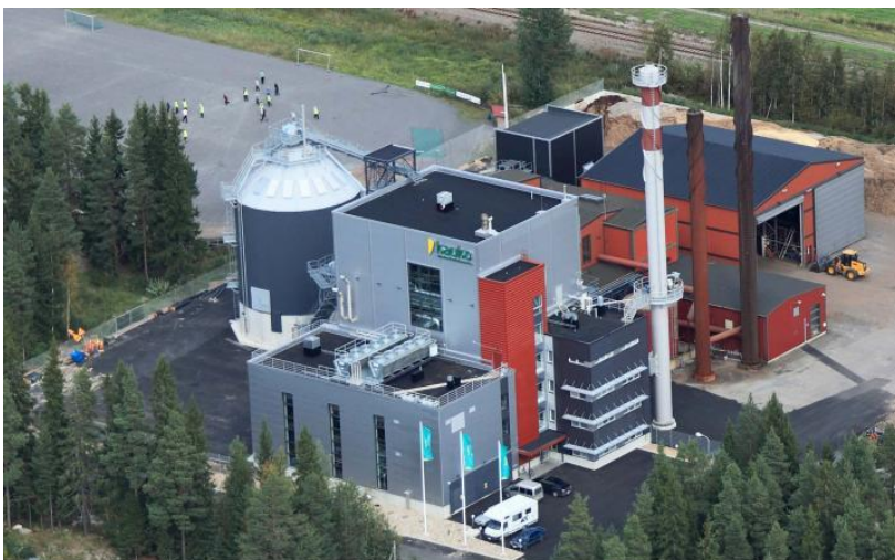
KUVA 8. Nivalan 20 MW:n CHP-laitos (14)
