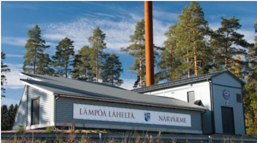
KUVA 9. Lapinjärven kirkonkylän kaukolämpölaite (15)
