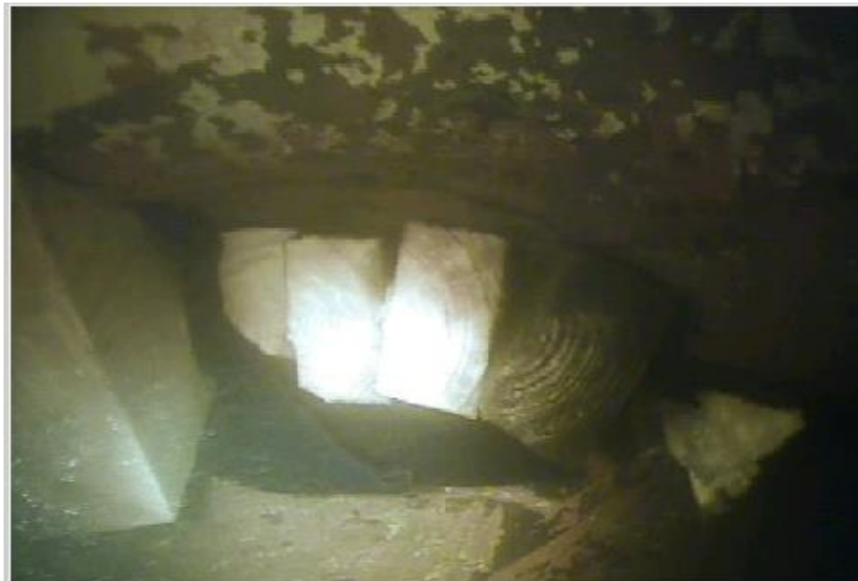
Kuva 11. Vaurion tilkkiminen puukiiloilla (Rannikon sukelluspalvelu Oy)
