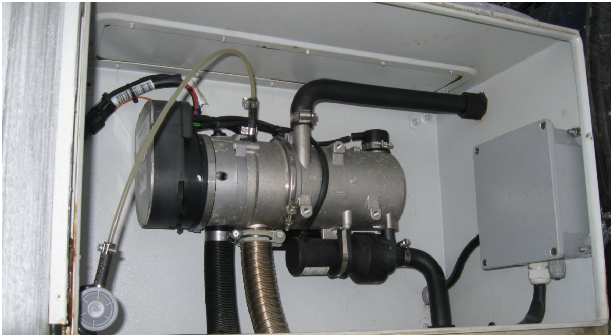
KUVA 4. Webasto Thermo 90 ST erillisen laatikon sisällä
