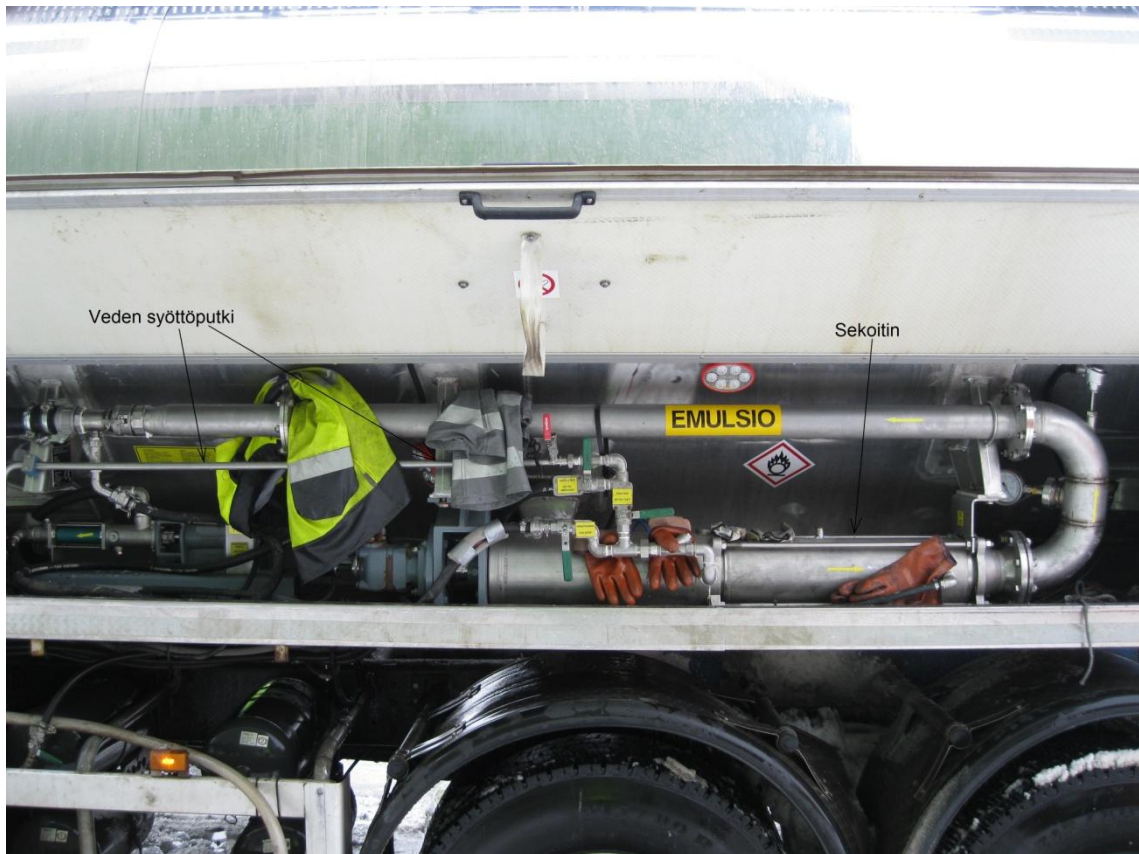
KUVA 10. Veden syöttöputki ja räjähdysainesekoitin (auton vasen puoli)
