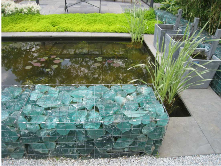
Kuva 11. Kivikorimuuri täytettynä koristeellisilla kierrätyslasiinpaloilla Appelternin näyttelypuistossa
