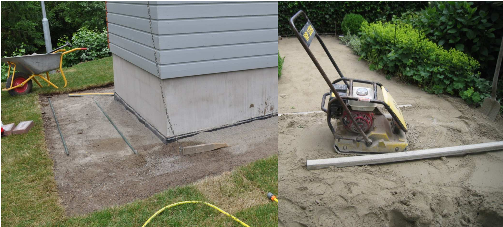
Vasemmalla uuden kiveyksen perusta Suomessa, oikealla Alankomaissa. Pohjamateriaalin karkeuden eron voi selvästi huomata.
