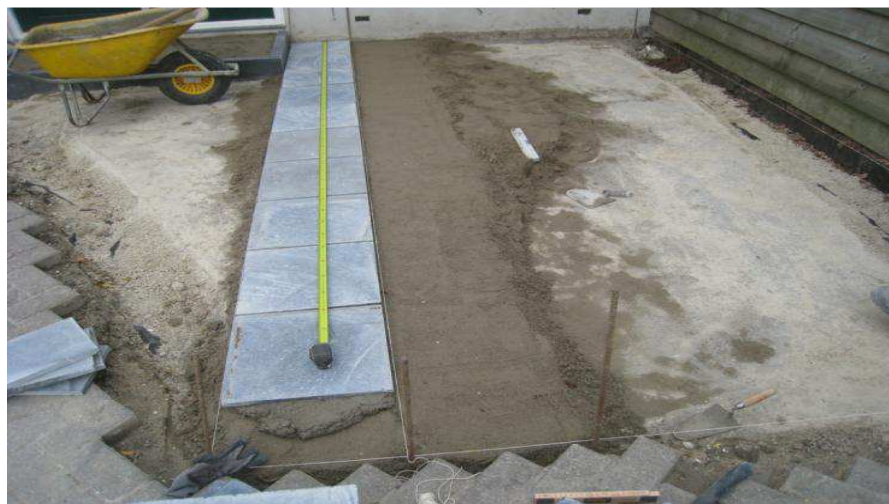
Kuva 14. Sinistä kalkkikivi-laattaa asennetaan betonimassan päälle linjalankojen, vatu-passin ja lasermitan avulla.
