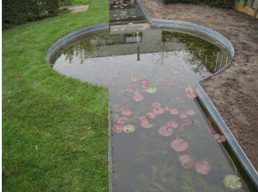
Kuva 8. Siirtonurmikkaa asennettuna sekä tiivistettyä kasvualustaa
