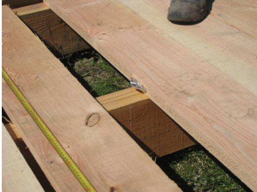
Kuva 20. Lautojen kiinnittämiseen käytettiin Lamello-metallilevykiinnitystä, jolloin lautoihin ei ruuvata pinnalle reikiä, eikä näkyviin jää ruuvinkantoja.
