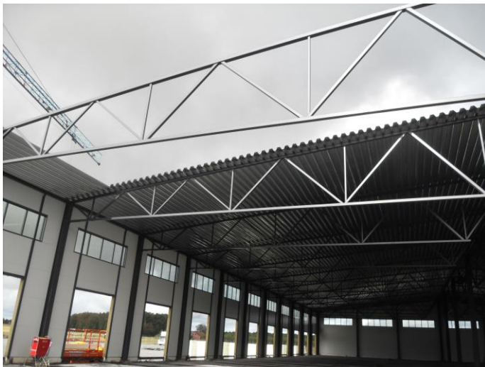
Kuvio 1. Kuva hallin sisältä rakentamisvaiheessa.
