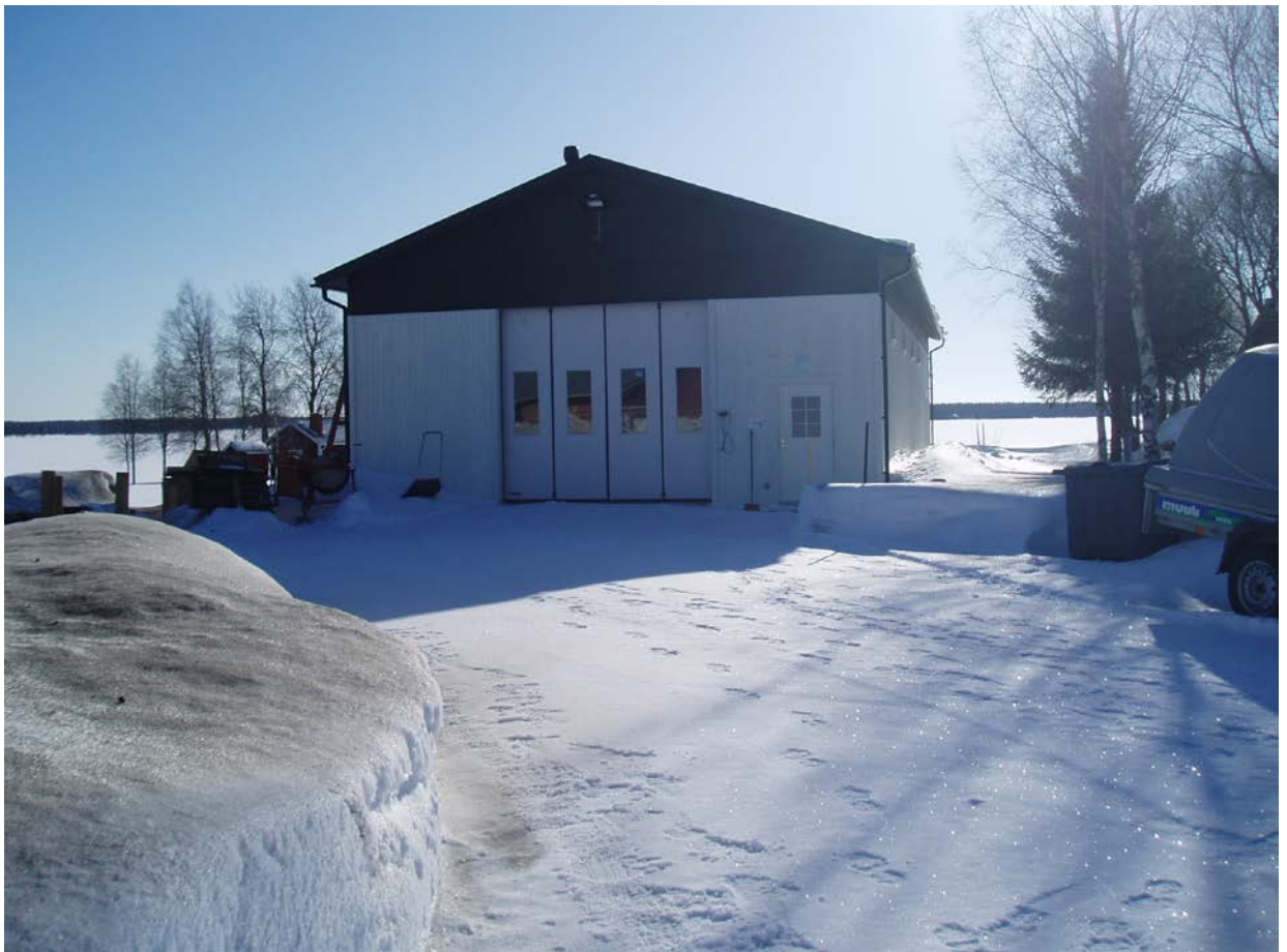
KUVIO 16. Rakennus ja Sähköpalvelu Korpi oy halli.
