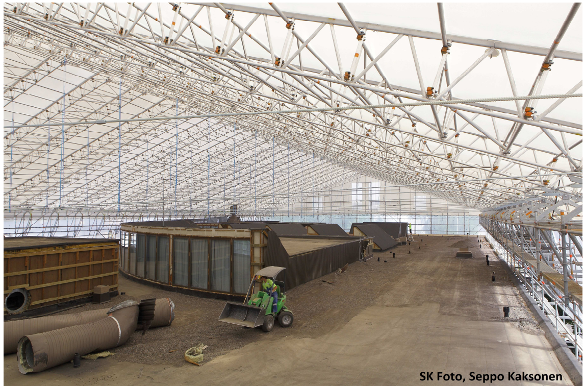
Kuva 1. Layher Keder Hall XL -sääsuoja Espoossa.
