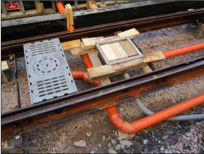
Kuva 9. KIEPE-kaivo asennettuna ennen pohjalaatan valua
