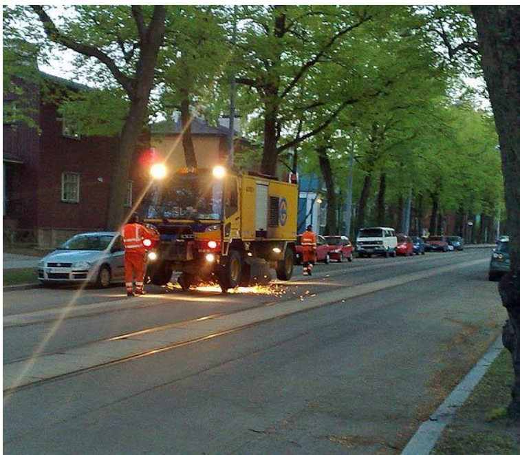
Kuva 18. Kiskoprofiilin hionta-auto toiminnassa Pohjolankadulla [7.]
