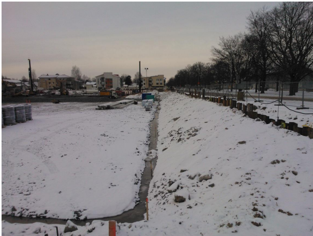
Kuva 15. Tukiseinä A. Kuva: Rosa Sirén 2013
