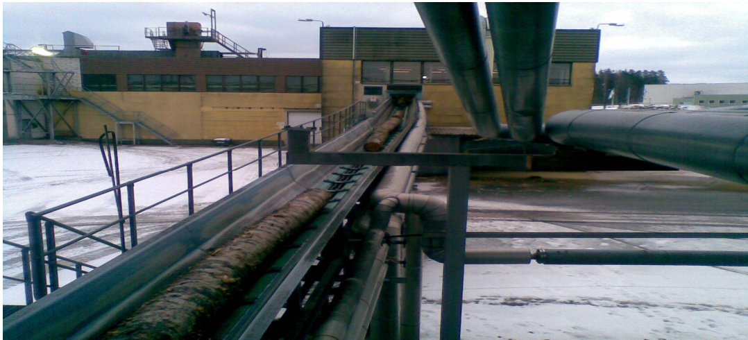
Kuva 8. Vaneritehtaan tukkien syöttölinja.
