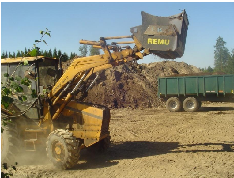
KUVA 2. Kaivurikuormaaja ja Remu-kauha kesällä 2008. (Vesa 2008).
