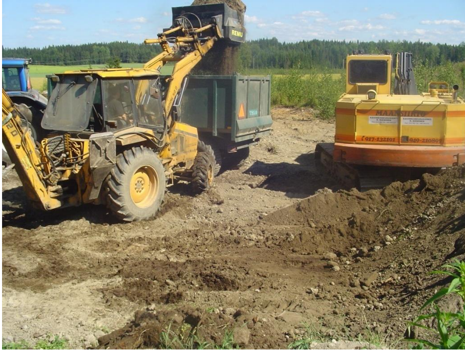
KUVA 3. Seulontatyö käynnissä. (Vesa 2008).
