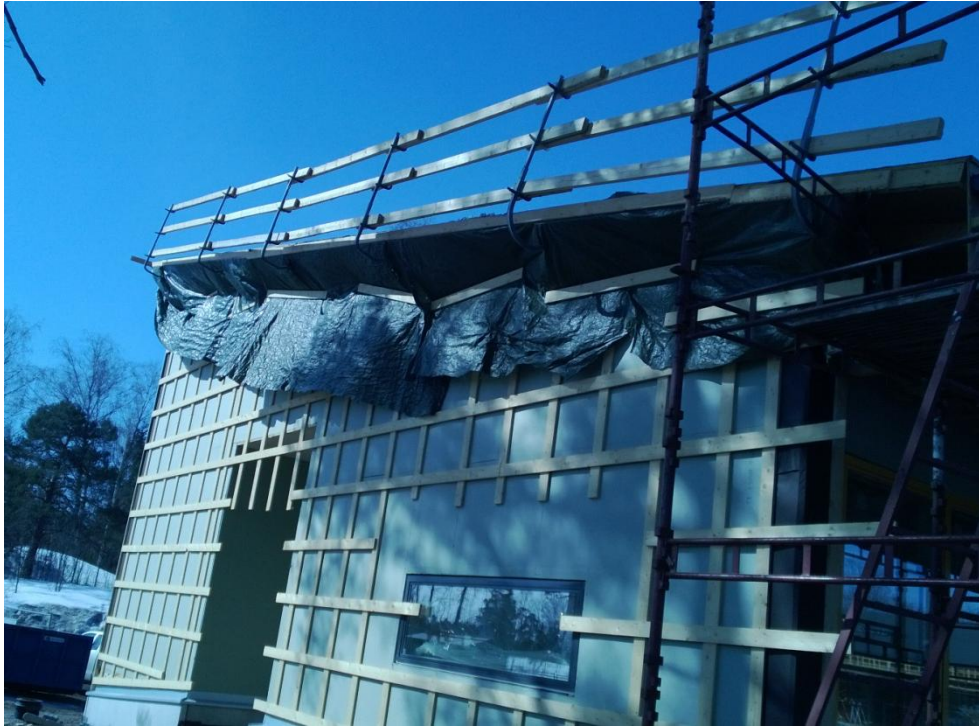
Kuva 17. Karhulan päiväkotityömaan vesikaton suojausten kiinnityksiä
