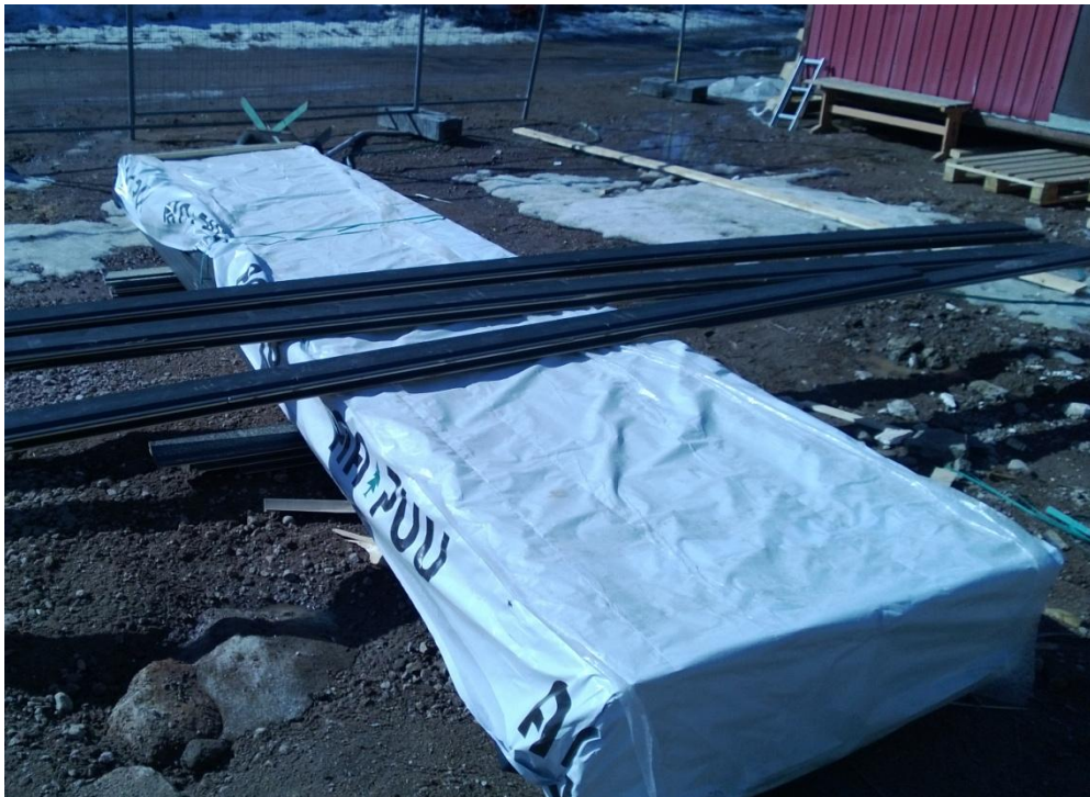
Kuva 18. Puutavaran suojaus
