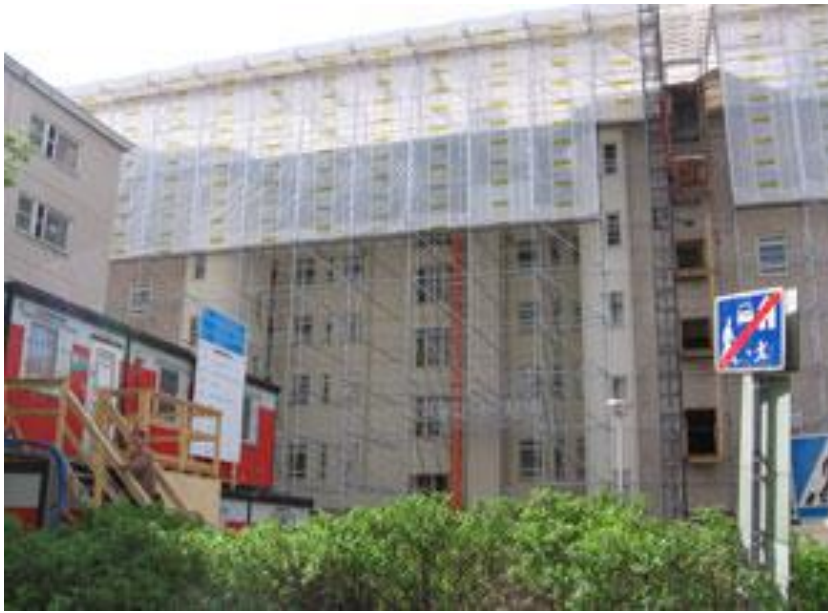
Kuva 9. Erään rakennuksen kunnostus telineisiin tuettujen sääsuojien avulla (Tompuri 2009)
