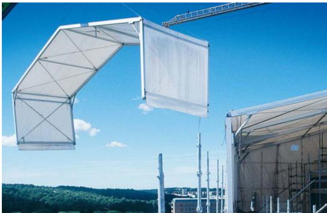
Kuva 11. Sääsuojan nosto nosturilla (Asiantuntevaa palvelua suojausprojekteihin)
