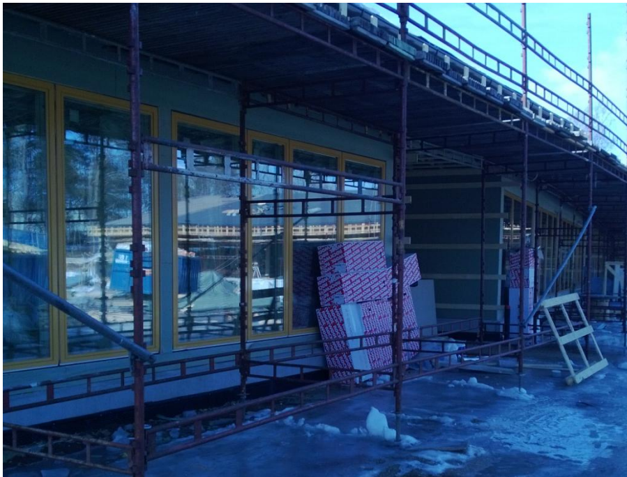
Kuva 19. Kivivillaeristeet suojattuna tehdassuojauksin katoksen alla
