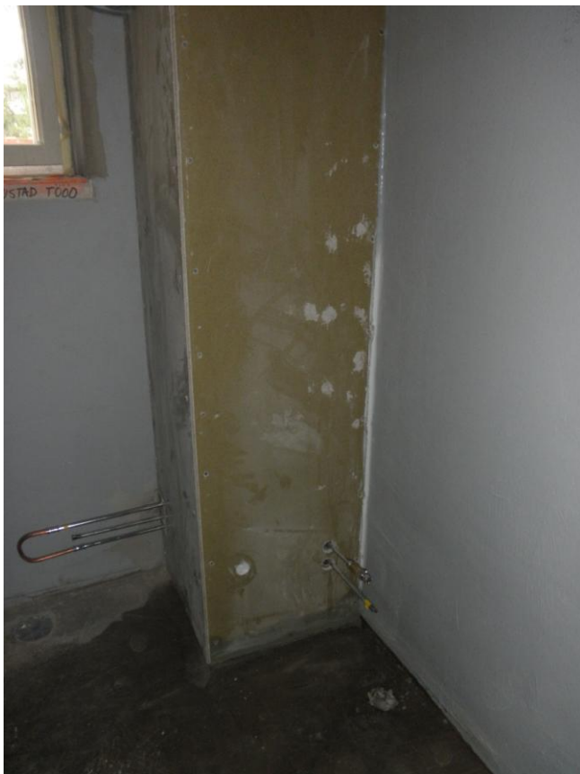
Kuva 8. Valmiiksi vedeneristetyistä levyistä tehdyn kotelo- läpiviennit, liitoskohdat, ruuvinkannat ja saumat on vielä vedeneristettävä. Saumoihin ja liitoskohtiin asennetaan vahvikekan- gas.
