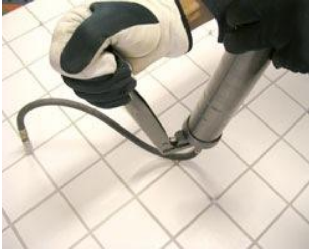
Kuva 15. Tulppien kautta pumpataan laatan ja kiinnityslaastin väliin epoksihartsia. Epoksihartsiliimaa laatan alustaan kiinni. Epoksi leviää koko kiinnitettävälle alueelle pienen paineen ja alhaisen viskositeettinsa ansiosta [15].
