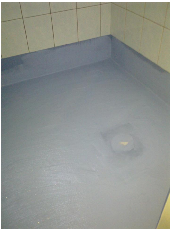
Kuva 13. Aluksi vedeneristetään ja laatoitetaan seinä, sen jälkeen vedeneristetään lattia.
