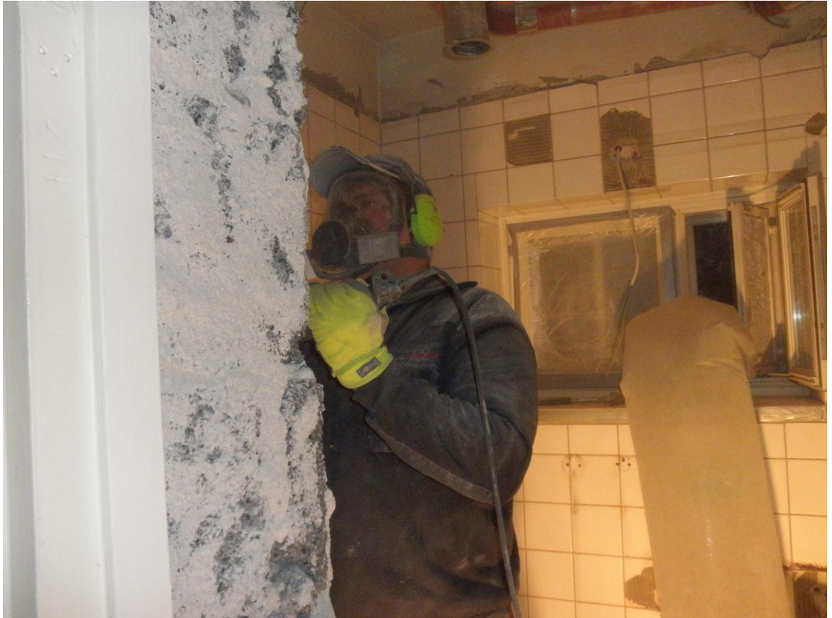
Kuva 5. Purkumiehellä on asiaankuuluvat suojavarusteet ja purettava tila on alipaineistettu.
