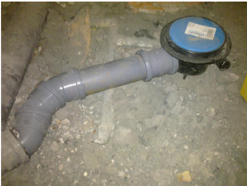
Kuva 10. Vedeneristysjärjestelmään yhteensopiva lattiakaivo.
