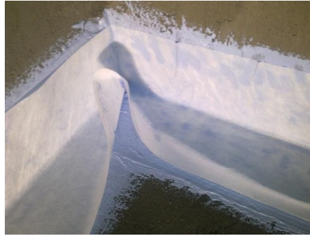
Kuva 1. Nurkkavahvikekangas painetaan märkään vedeneristysmassaan
