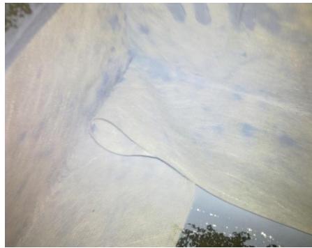
Kuva 2. Ylimääräinen kangas taitetaan kolmio muotoiseksi ja liimataan massalla
