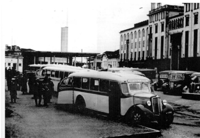
Kuva 24. Sortavalan linja-autoasema 1930-luvun lopulla. (Piltz 2005,37) Asemarakennus kuvassa vasemmalla.
