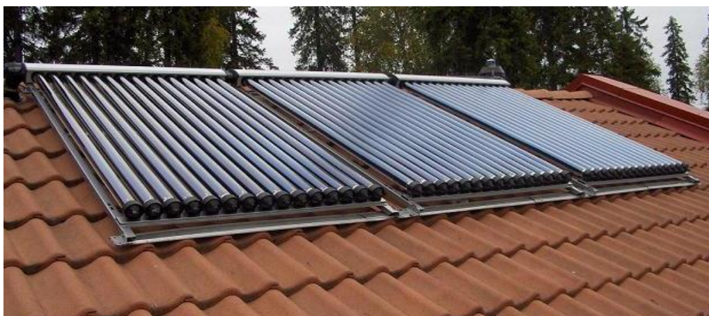
Bild 18. Solfångare installerade på taket (Sepratec Oy, 2008).
