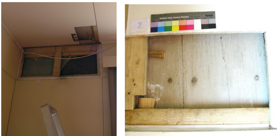
Kuvat: 17 ja 18: Katon esiinottoaukko 2 ja aukon sijainti. (Kuvat: Jenni Jokinen.)
