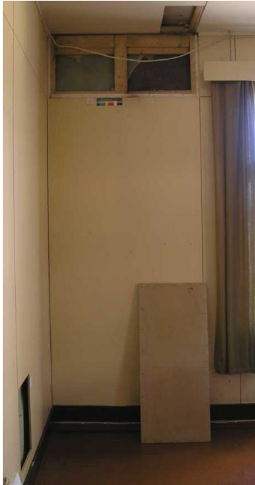
Kuva 28. Seinän esiinottoaukon 6 sijainti. (Kuva: Jenni Jokinen.)
