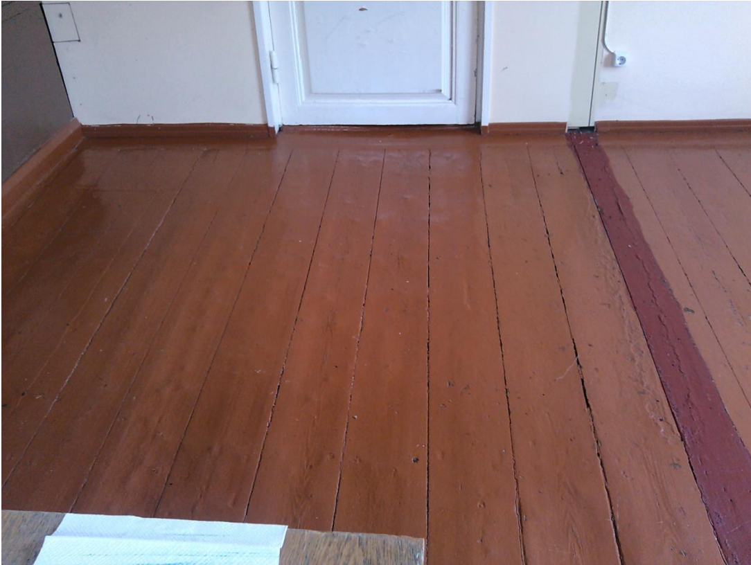
Kuva 11. Lattiaa hellan vierestä pitkän oviseinän suuntaan. (Kuva: Jenni Jokinen.)
