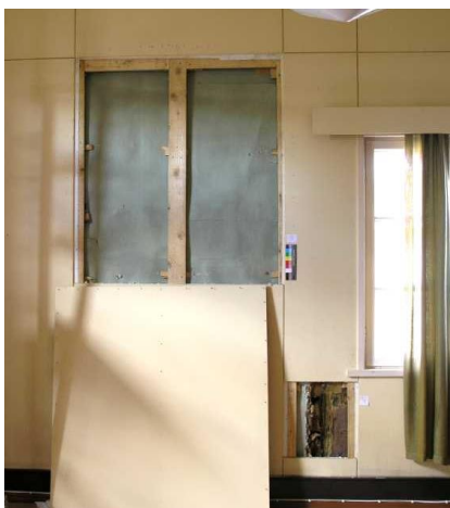
Kuva 34. Seinän esiinottoaukko 9. (Kuva: Jenni Jokinen.)
