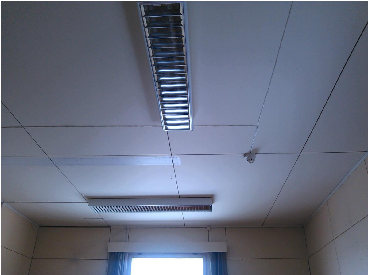
Kuva 10. Katto lyhyen ikkunaseinän suuntaan. (Kuva: Jenni Jokinen.)
