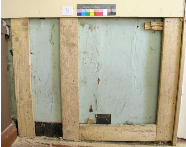
Kuva 33. Seinän esiinottoaukko 8. (Kuvat: Jenni Jokinen.)
