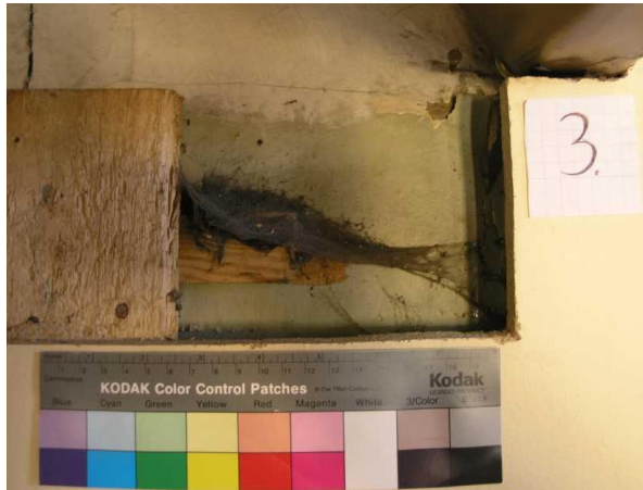
Kuva 23: Seinän esiinottoaukko 3. (Kuva: Jenni Jokinen.)
