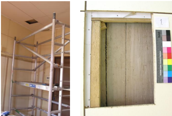
Kuvat 15 ja 16. Katon esiinottoaukko 1 ja aukon sijainti. (Kuvat: Jenni Jokinen.)
