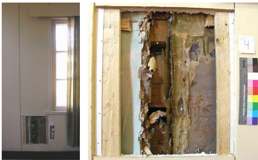
Kuvat 24 ja 25. Seinän esiinottoaukko 4 ja aukonsijainti. (Kuvat: Jenni Jokinen.)
