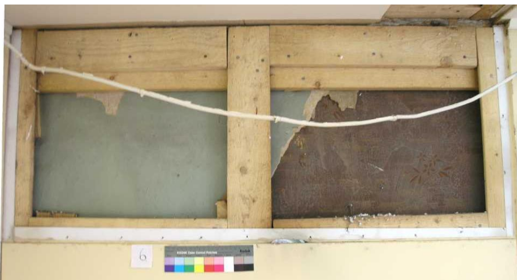
Kuva 29. Seinän esiinottoaukko 6. (Kuva: Jenni Jokinen.)
