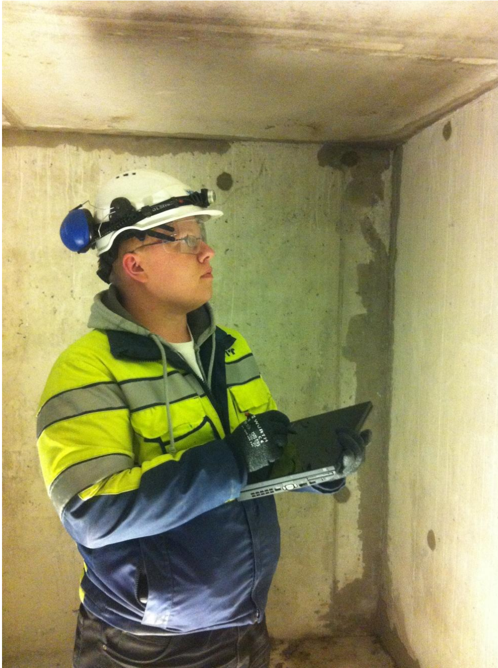
Kuva 10. Kuvassa työnjohtaja Akseli Jalava on tarkistamassa elementtien asennuksen laatua ja kirjaamassa puutteita pohjakuvaan.
