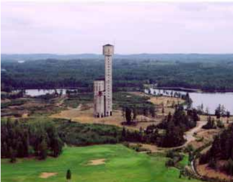
KUVA 12. Keretin vanha kaivostorni näköalatornina.
