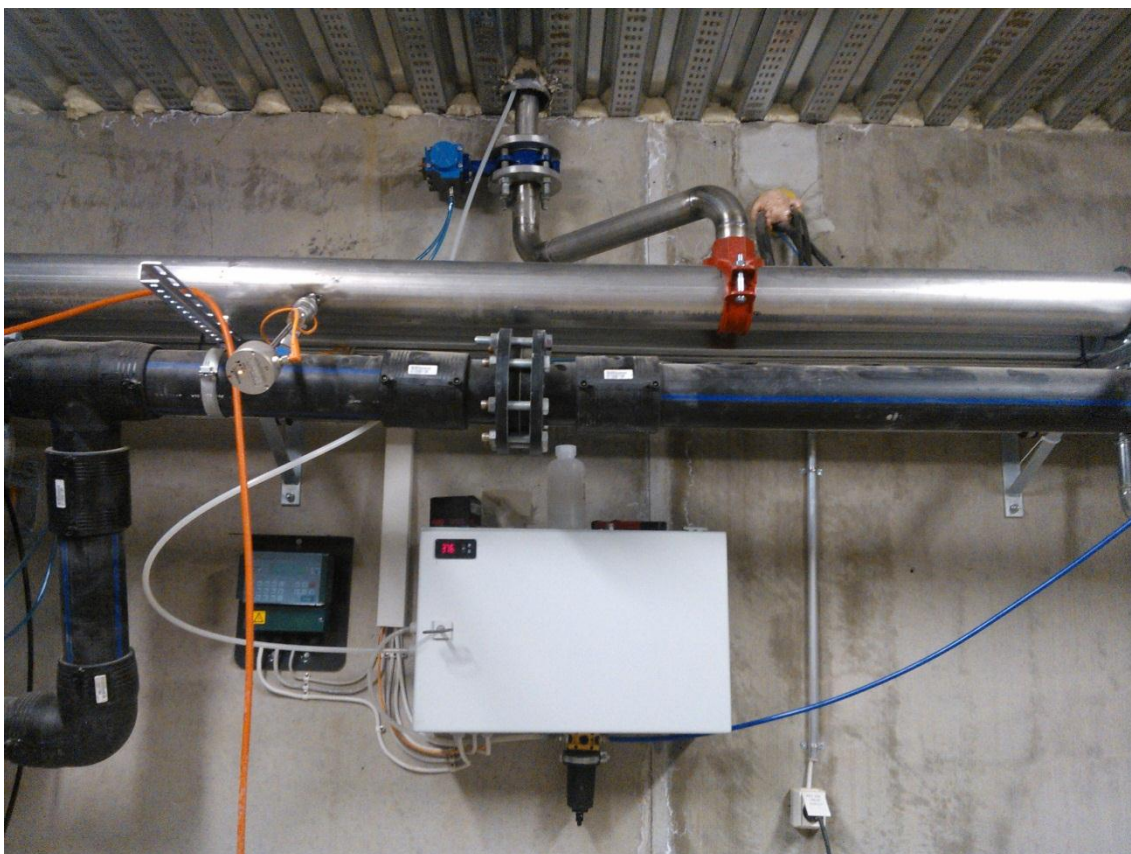
Kuva 4. Online-anturit sisältävä kaappi, jonka vasemmasta yläkulmasta näet reaktorilietteen tarkan lämpötilan.
