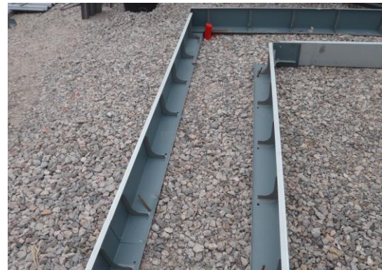
KUVA 16. Recostal-perustusmuotti Speed.
