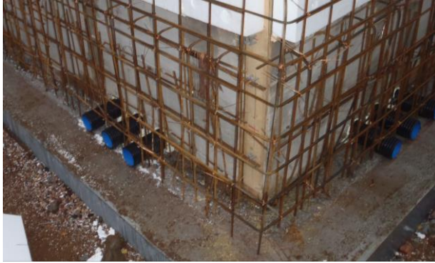
KUVA 21. 4) Speed-profiilisen metallimuotin talotekniset varaukset anturan päältä
