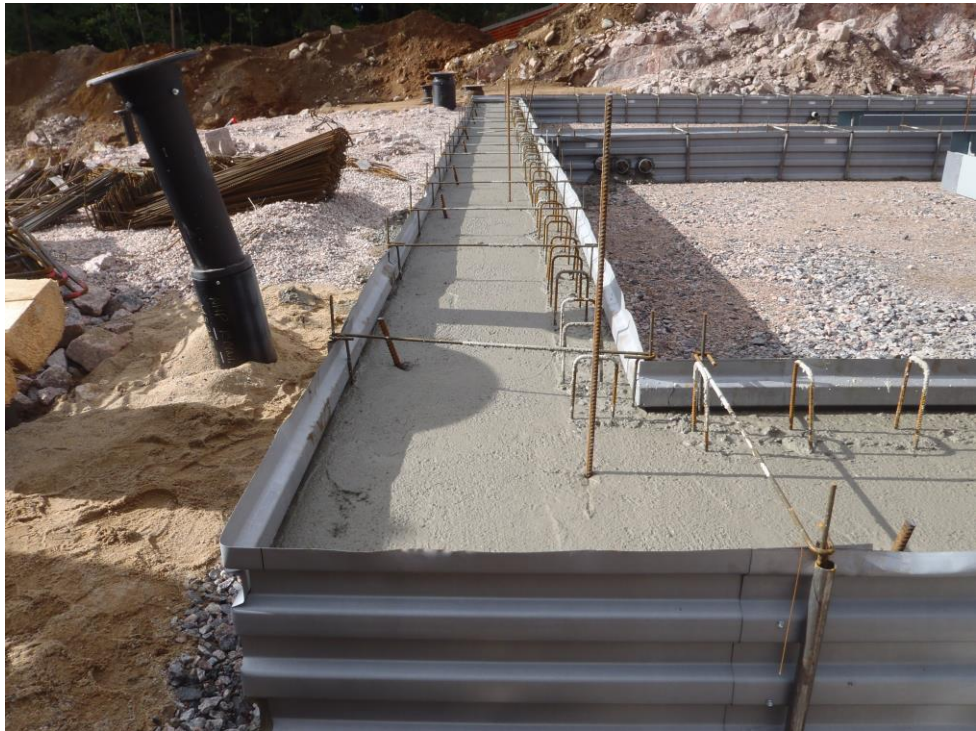
Rakennukset 1...10, Elementtitartunnat RAK P-100-1-19 Talon 5 Sivut valettu ja elementtitapit asennettu.
