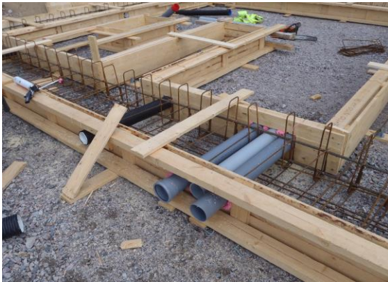
KUVA 5. Sähkövarausputkia
