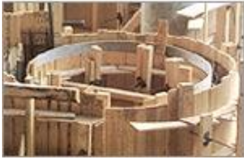
KUVA 23. Lautamuottijärjestelmä
