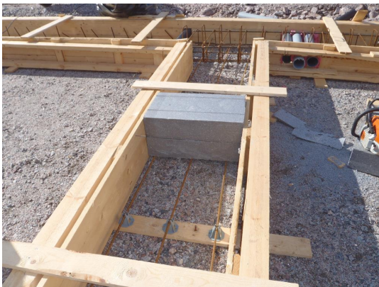
KUVA 6. Vesiputkenvaraus
