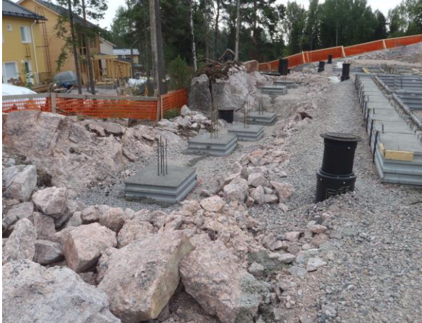
KUVA 17. Recostal-perustusmuotti ET
