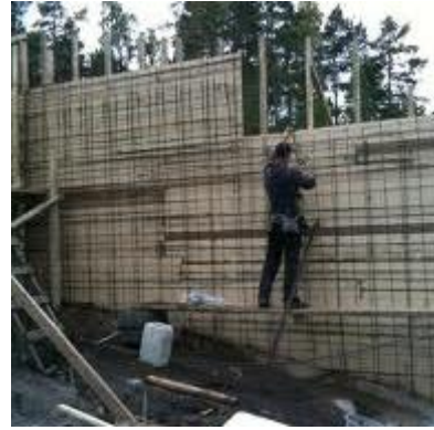
KUVA 24. Levymuottijärjestelmä
