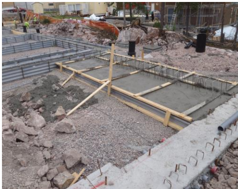
KUVA 15. Speed-profiilin ylähelman lisätuenta tukimuurianturassa.
