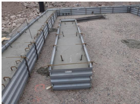
KUVA 19. 2) Menettely pysty- ja ulkosidoksen päät taitettuna.
