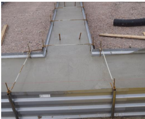
KUVA 18. 1) Menettely sidoksen päitä taittamatta.
