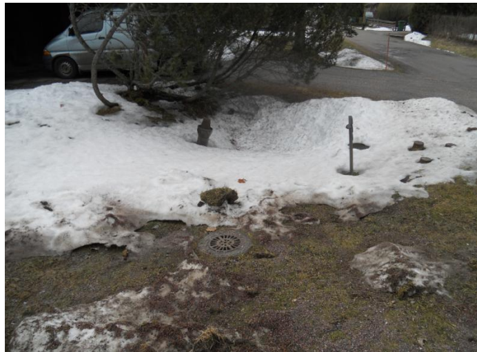
Kuva 19. Viinenkujan ja Yrjönnyntien risteys. Hulevesikaivo luiskassa.
