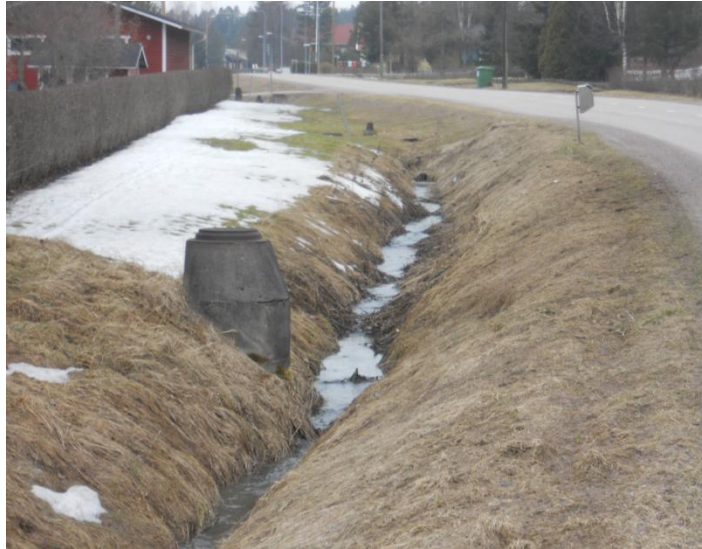
Kuva 13. Kapea tila lähellä rakennetun hulevesiviemärin purkuputkea.
