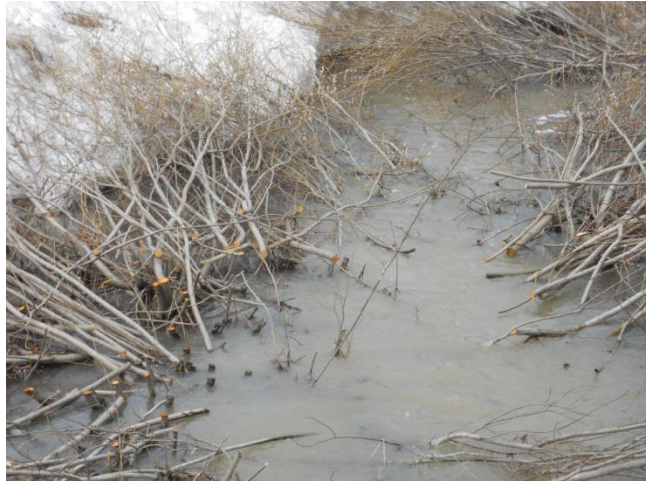
Kuva 18. Purkuojasta raivattua pensaikkaa, joka on jätetty ojaan.
