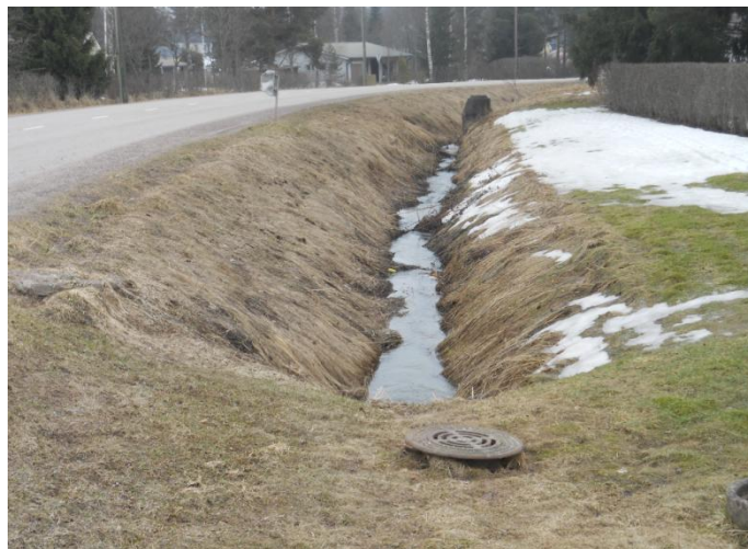
Kuva 15. Hulevesirunkoviemärien liittäminen rakennettuun.
