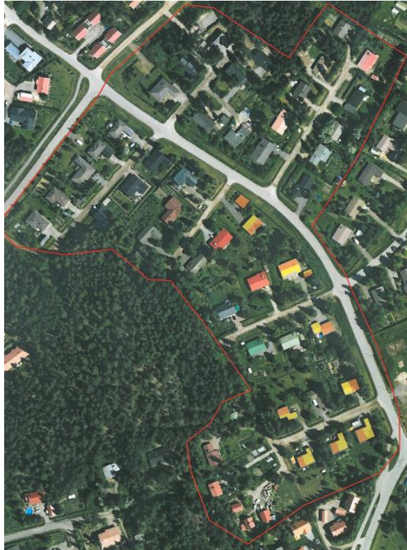
Kuva 8. Ennen urakointia tutkittavat rakennukset.
