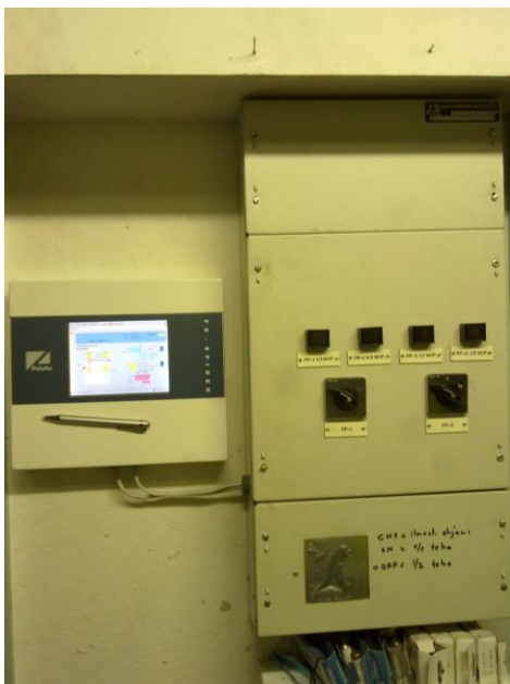
Kuva 38. Spider sähköpääkeskuksessa
