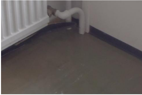
Kuva 11. Vinyylilaattoja ja jalkalista
