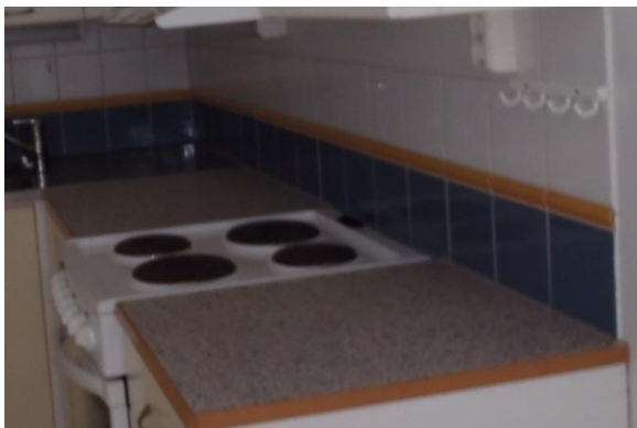
Kuva 13. Asuinhuoneiston keittiön välitilan laatoitus
