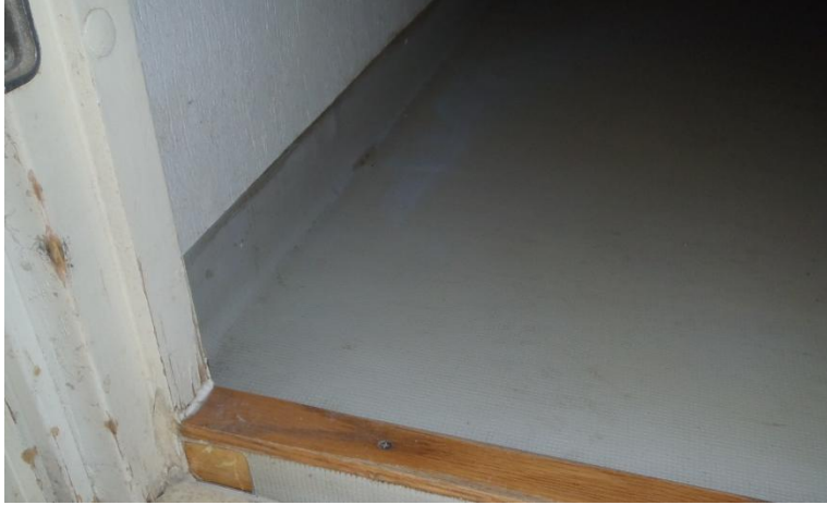
Kuva 14. Asuinhuoneiston pesuhuoneen muovimatto ja muovitapetti
