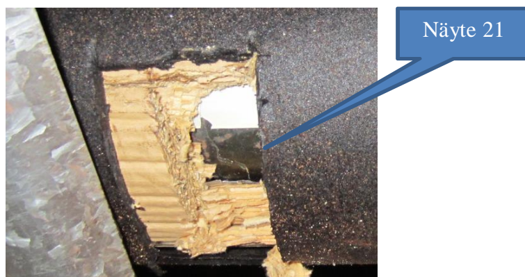
Kuva 8. Tervapahvi + aaltopahvikouru + alumiinilaminaattipaperi
