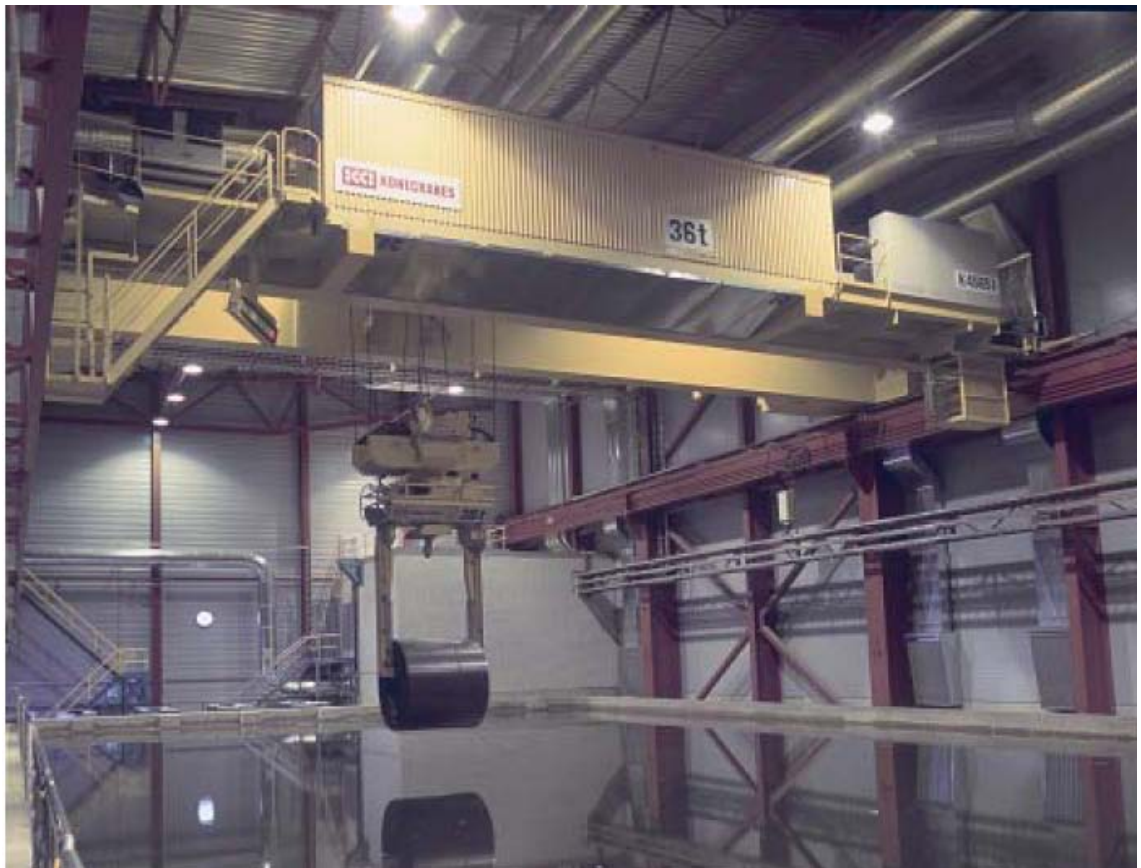
KUVA 7. Metallirullavarastonosturi, jossa nostinlaitteena pihtinostin (Coil Storage, 25)
