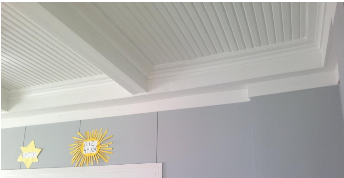
Kuvio 4. Kolmessa alakerran huoneessa on alkuperäinen sisäkattopanelointi.
