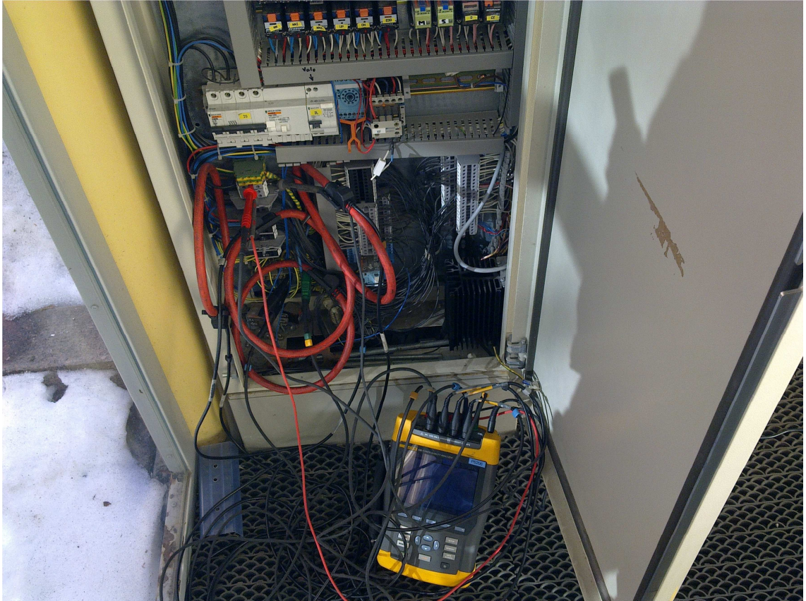
Kuvio 14. Mittauslaitteisto kytkettynä Semagin ohjauskaappiin.
