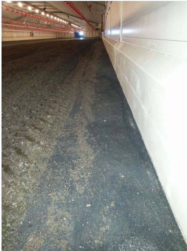
Kuva 1. Levittämätön alue seinän vieressä.
