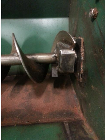
Kuva 6. Kuvassa näkyy kairan ja hydraulikkamoottorin liitoskohta.
