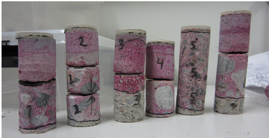
Kuva 1. Poratut tutkimusnäytteet. Pintabetonin osa näytteissä on katkennut jo irrotusvaiheessa. Näytteiden sinipunertava väri johtuu fenoliftaleiiniliuksesta. Värjäytymätön osa on karbonatisoitunutta. Kivet eivät kaikki pinnoitemateriaalit karbonatisoidu kuten betonin sementtiliima. Näytteen 2 kantavan rakenteen näyteosa on katkennut irrotusvaiheessa. Näytteen 5 betoni vaikuttaa erityyppiseltä kuin muiden näytteiden ja siinä ei ollut erillistä pintabetonikerrosta.
