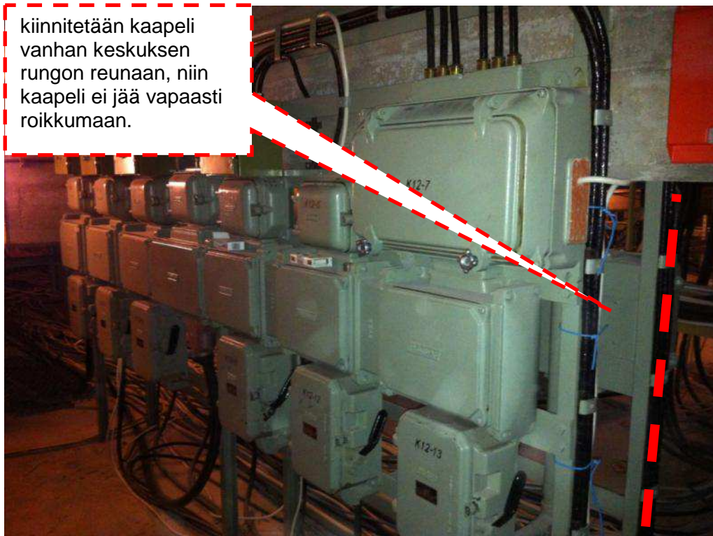
Kuva 25. lattialämmityskaapelin reitti lattialta kattoon.
