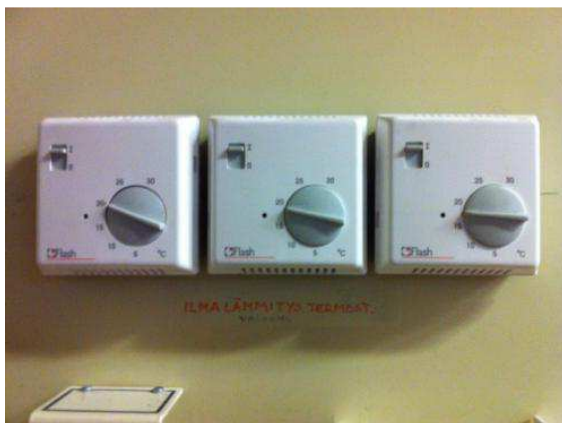
Kuva 14. Ilmalämmityksen nykyiset termostaatit
