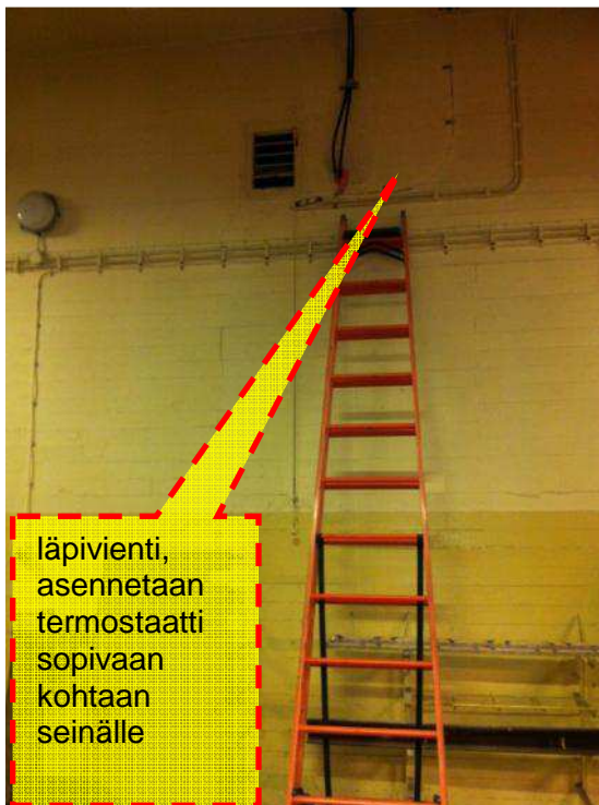
Kuva 18. Termostaatin asennuspaikka
