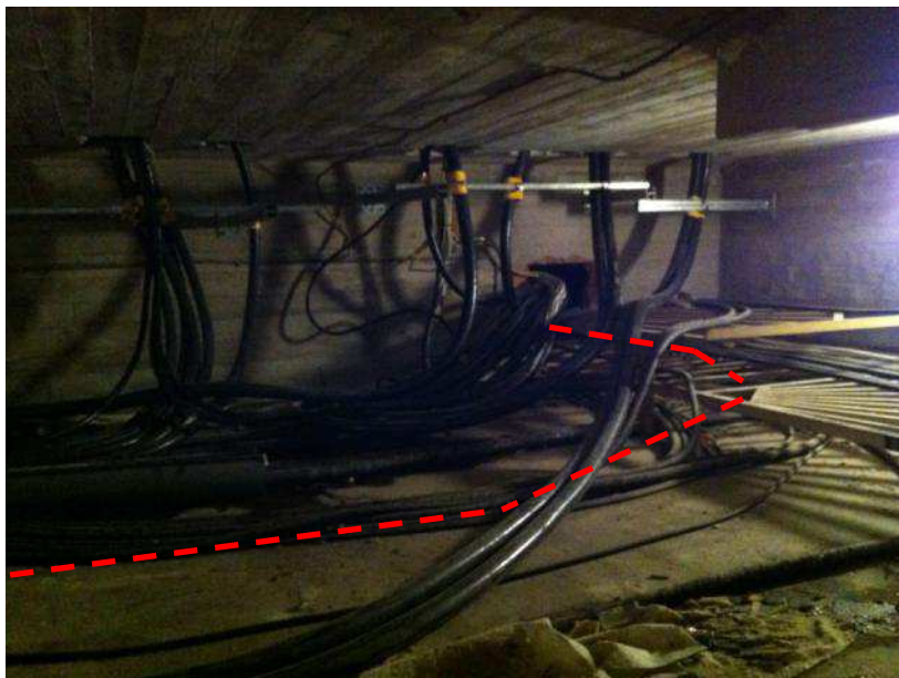
Kuva 16. Syöttökeskuksen kaapelitila
