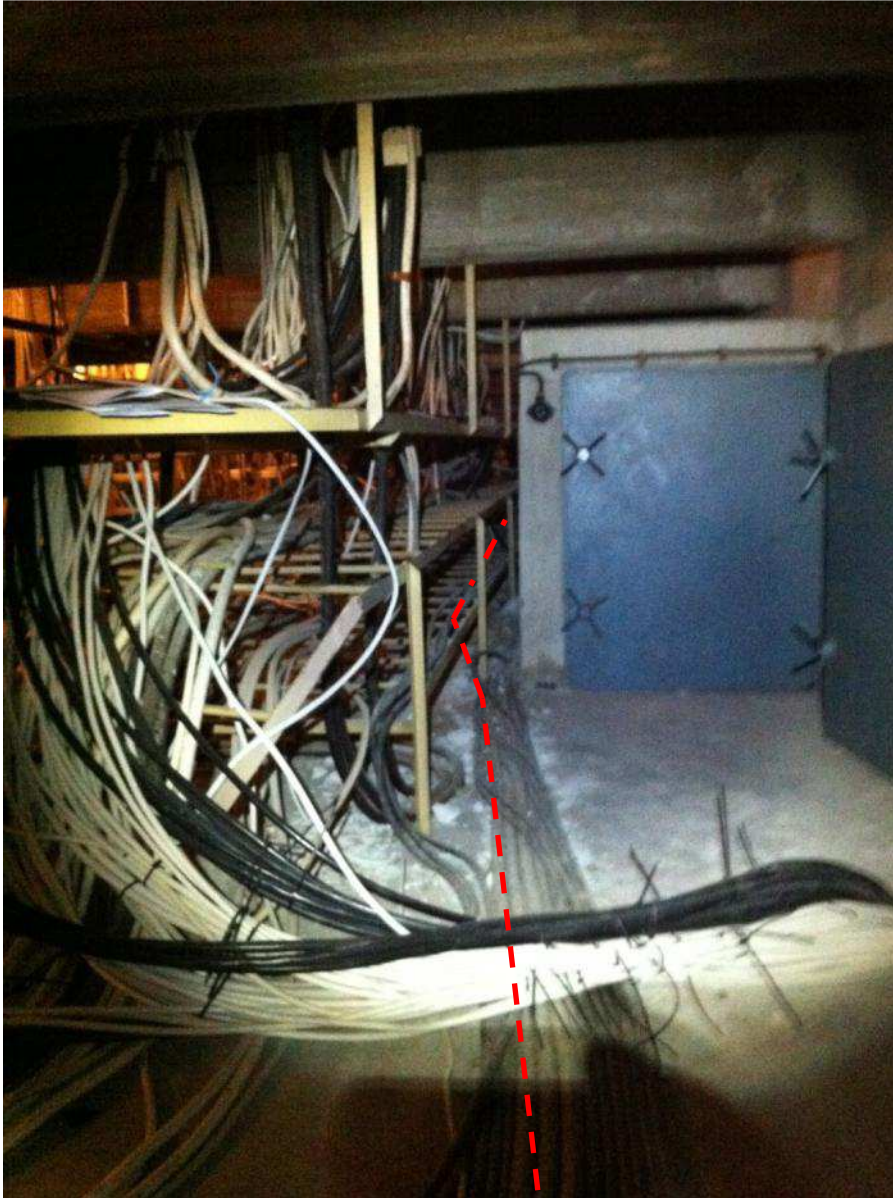
Kuva 24. kaapelireitti kaapelitilassa
