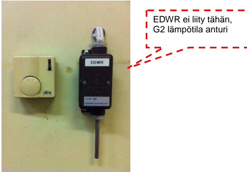
Kuva 27. Lattialämmityksen termostaatti.
