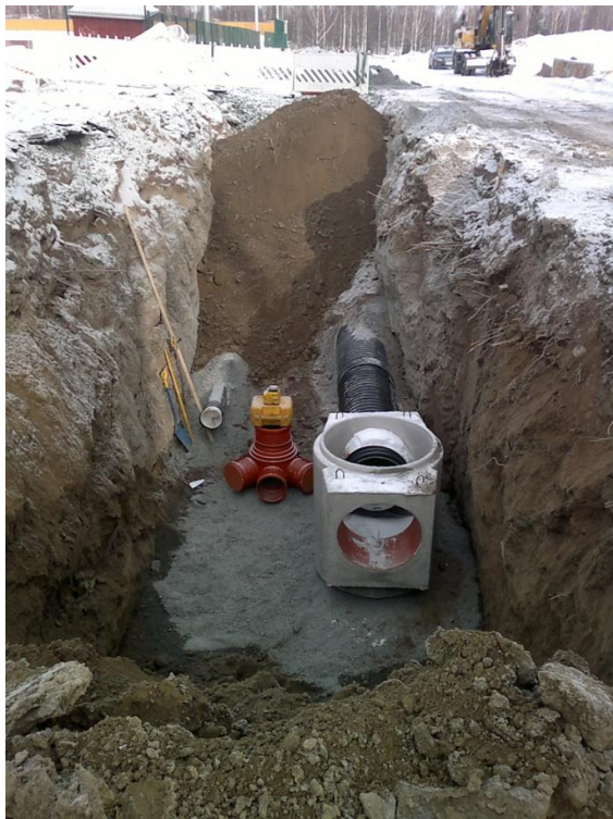
KUVA 2. Putkien asennus (Kuva: Risto Holmi 2012)
