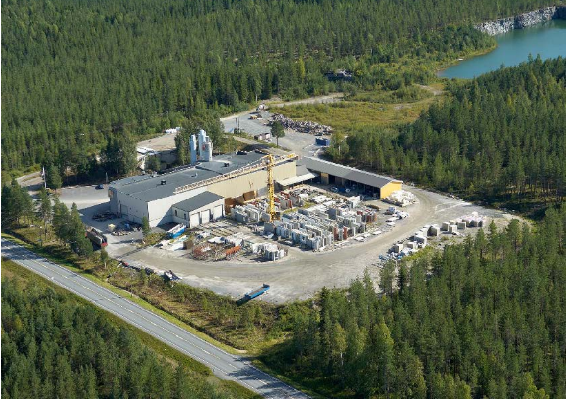
Kuvio 1. Alavuden Betoni Oy:n betonielementtitehdas vuoden 2012 alussa (Raisio 2012).
