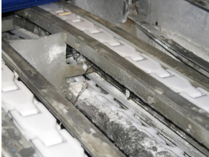
KUVA 15 Oikean puoleinen ketju ei ota kunnolla kiinni laatikkoon
