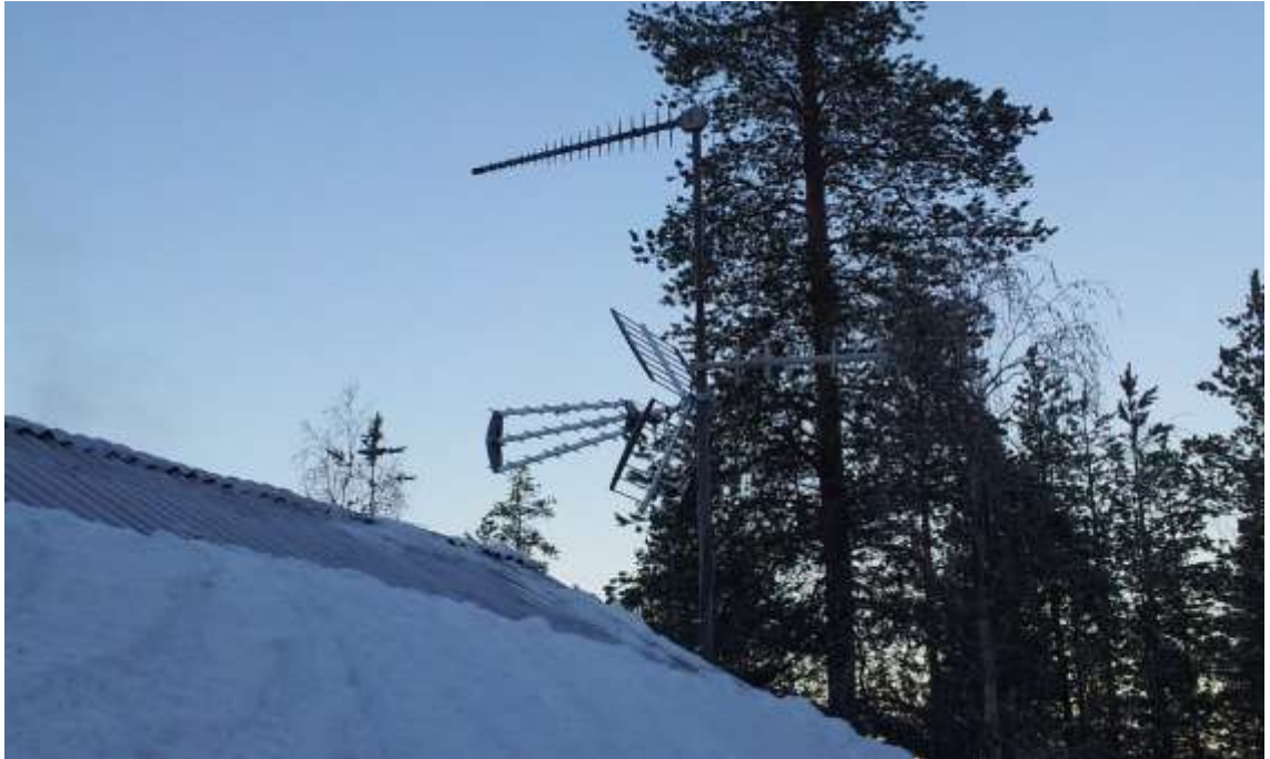
Kuva 13. Antennit asennettuina katolle
