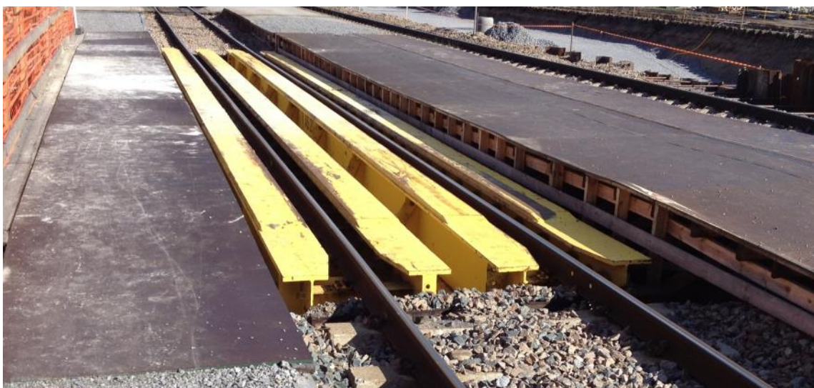
KUVA 2. Apusilta AS 20-14 asennettuna Pännäisissä
