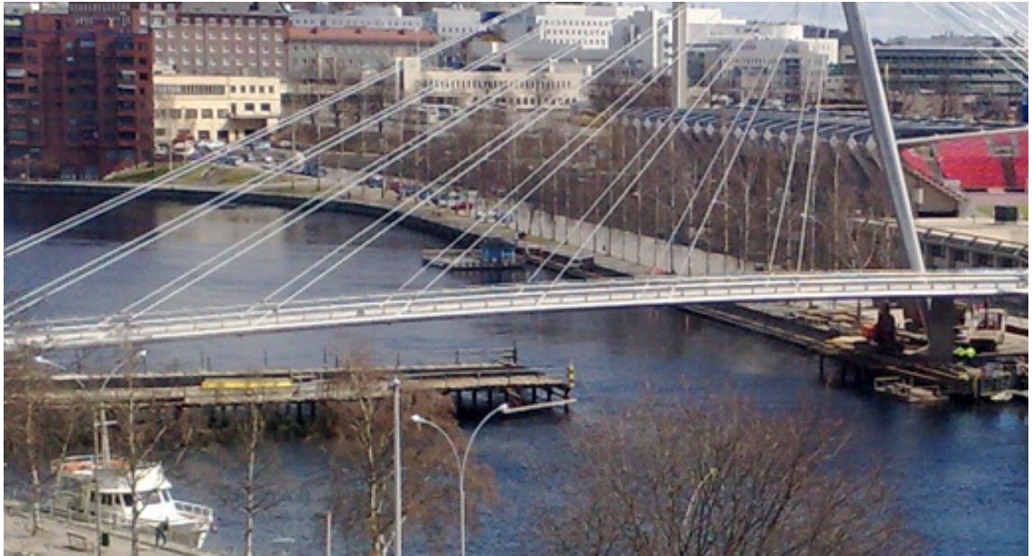
KUVA 15. Työsilta laukonsillan alla (Nimimerkki grendy, 2010.)
