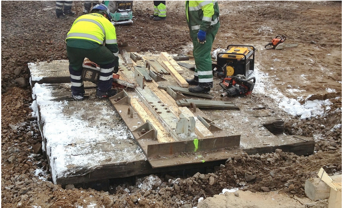
KUVA 4. Laakerikiskon asennus Pännäisissä
