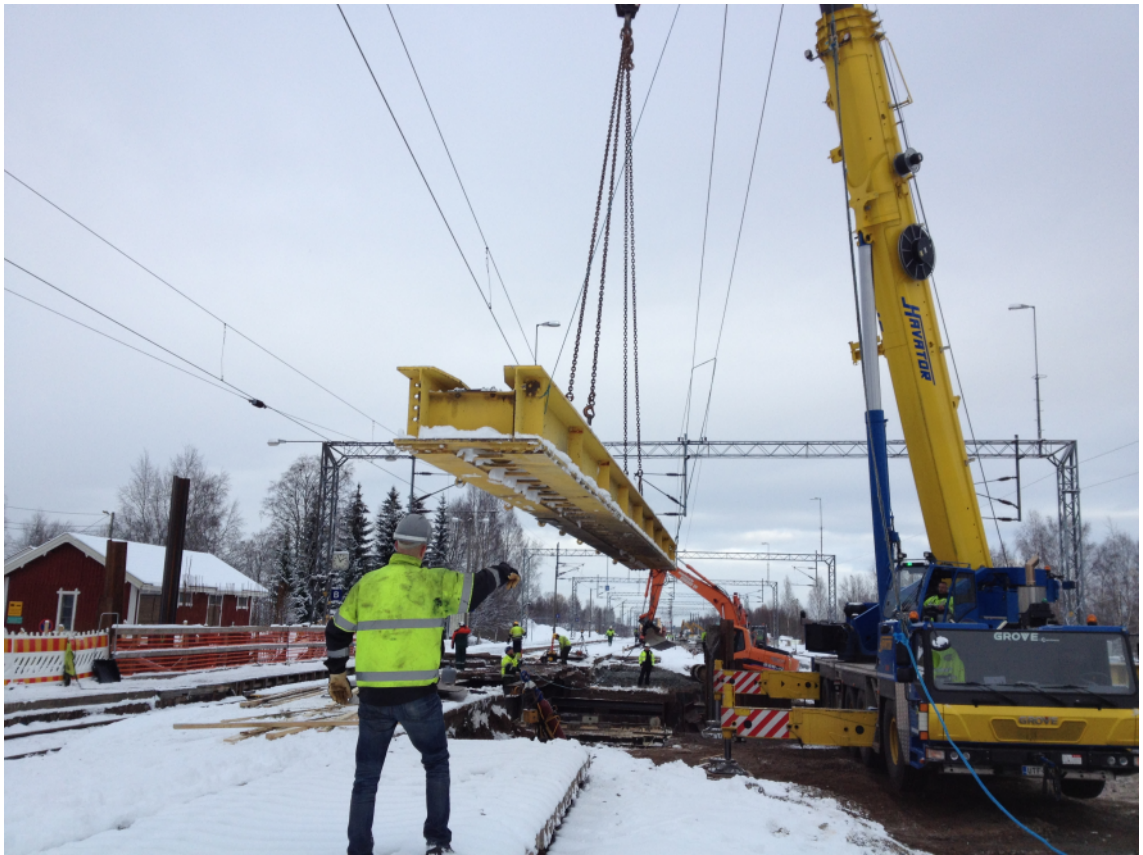
KUVA 5. Apusilta puolikkaan paikoilleen lasku ajojohtimien välistä
