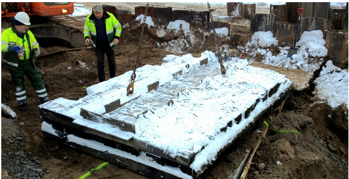
KUVA 3. Ratapölkkyperustuksen asennus Pännäisissä
