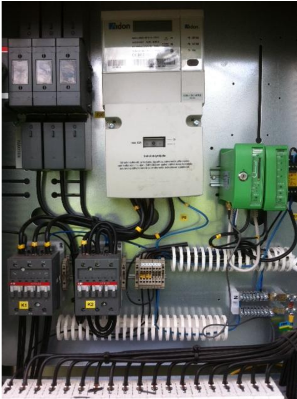
KUVA 13. C2 SmartLight –ohjausjärjestelmällä toteutettu katuvalokeskus.
