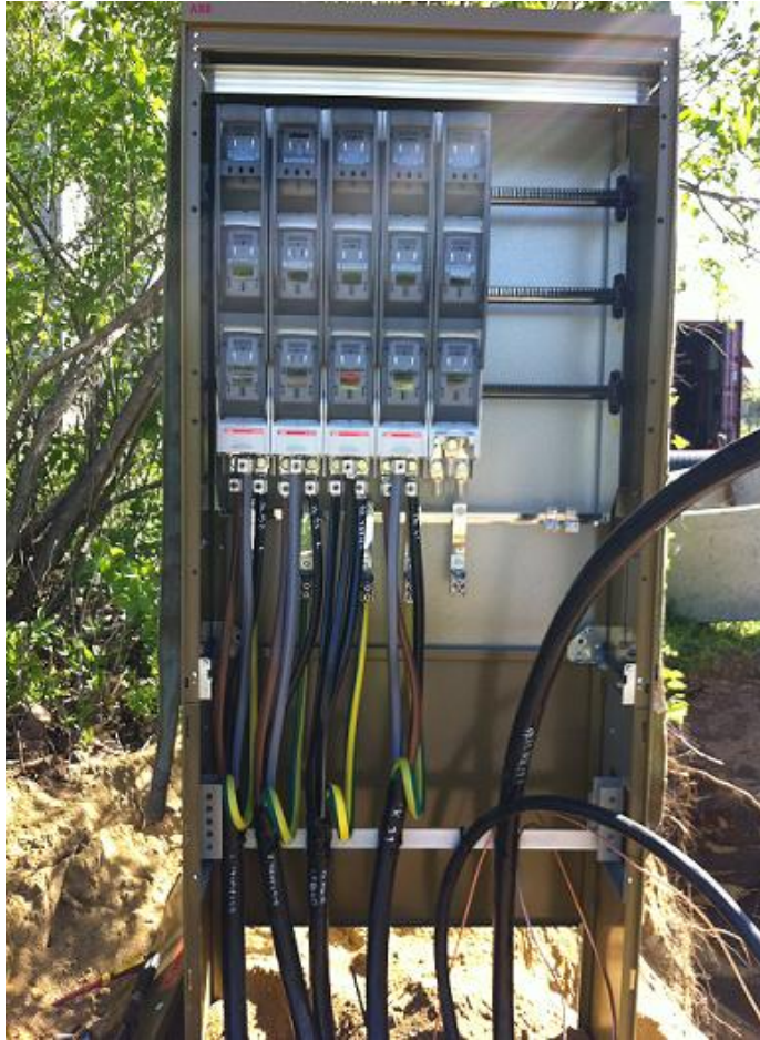
KUVA 7. Jakokaappi kytkentävaiheessa
