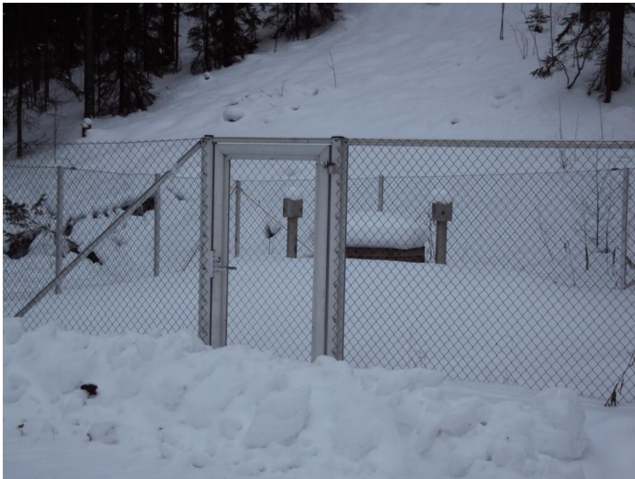
KUVA 4. Rehniönniemen uudempi vedenottoaivo (Kosunen 2013).
