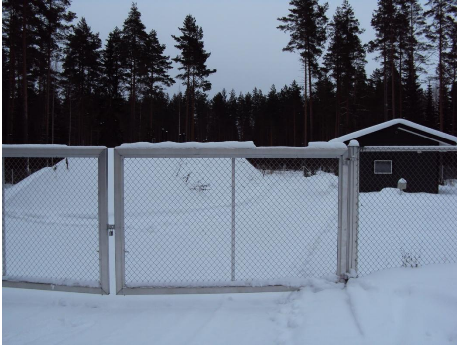
KUVA 5. Vilkonharjun vedenkäsittelylaitos (Kosunen 2013).
