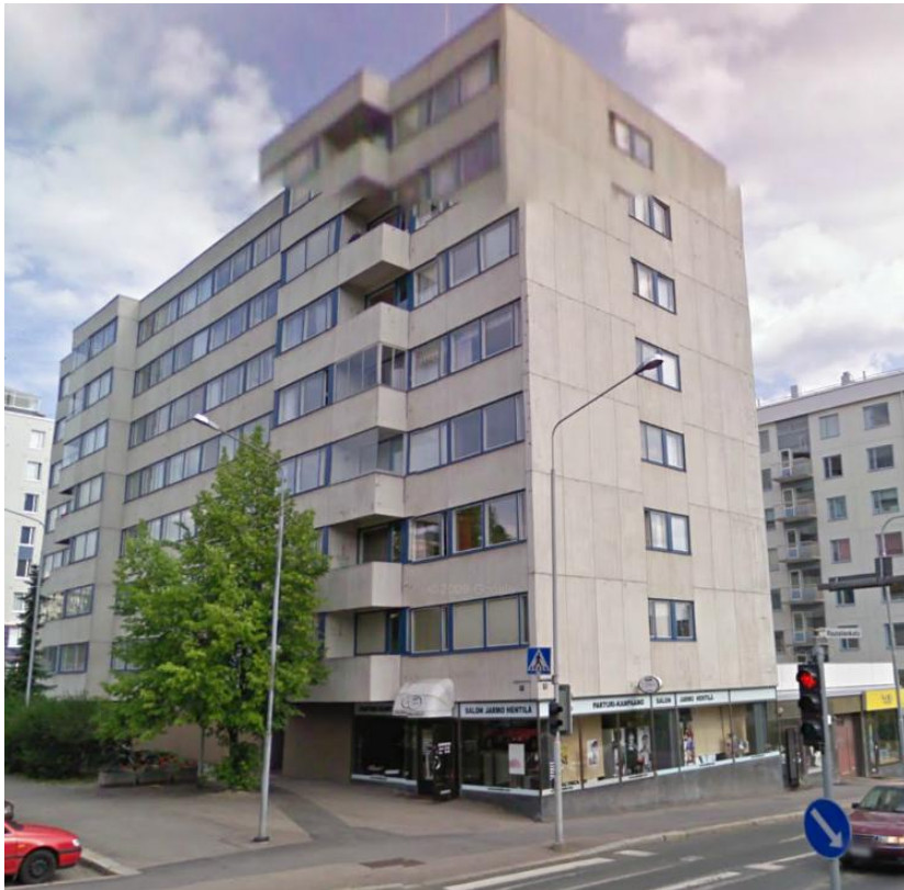
KUVA 1. As Oy Satakunnankatu 5 ennen julkisivuremonttia
