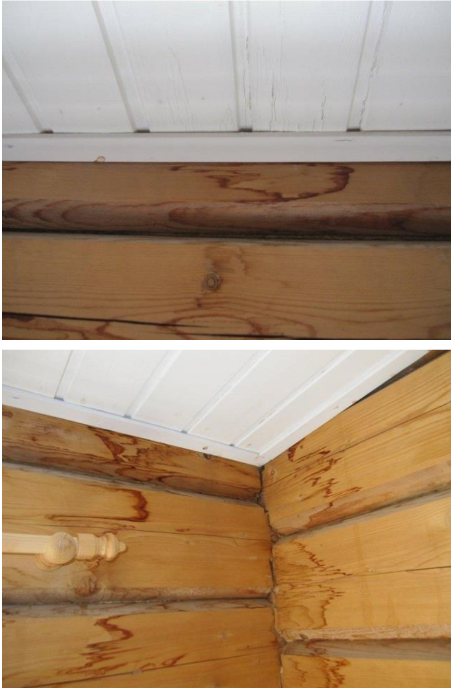
Bild 16. Stockstuga i skärgården utan brädfodring där vatten trängt in i stockarna. (Karlsson 2013)
