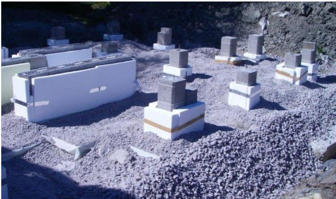
Bild 11. Pelare bör isoleras för att undvika problem med tjälen. (Karlsson 2013)
