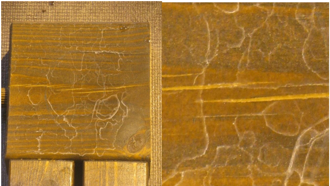
Kuvio 22. Vääntymisestä johtuva pinnan halkeaminen.
