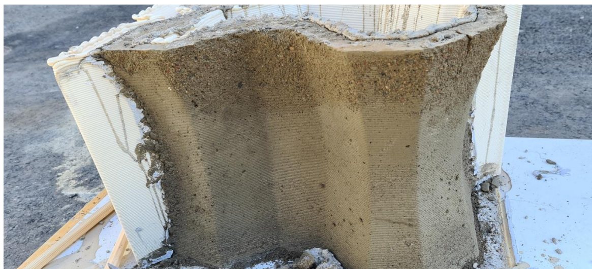
KUVA 7 Monimuotoinen betonivalu, avattu muotti (Sormunen 26.4.2020)
