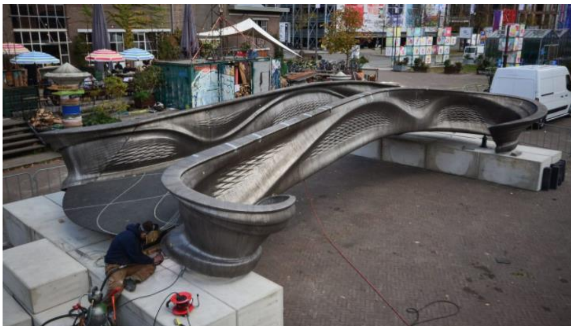
KUVA 1 Hollannissa metallista tulostettu silta (Archdaily.com 2018)
