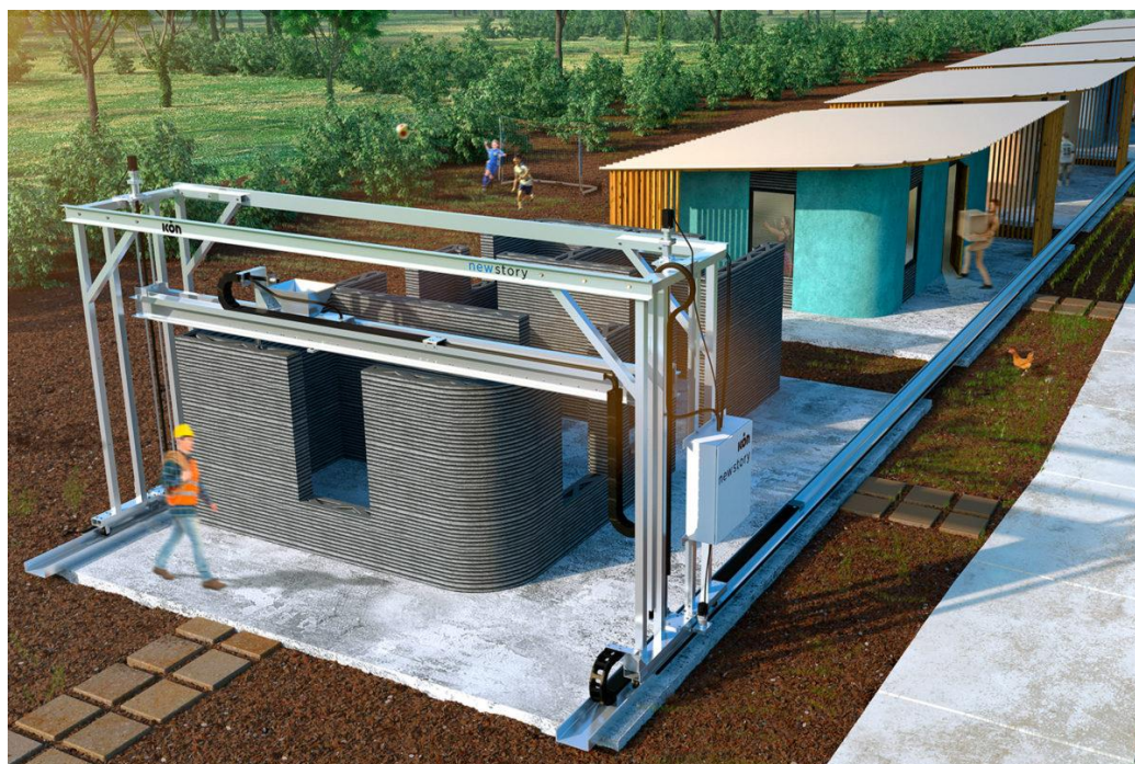
KUVA 3 Betonin suoratulostus, kiskoilla kulkeva tulostinpää kuvituskuva (3Dnatives 1.9.2021)
