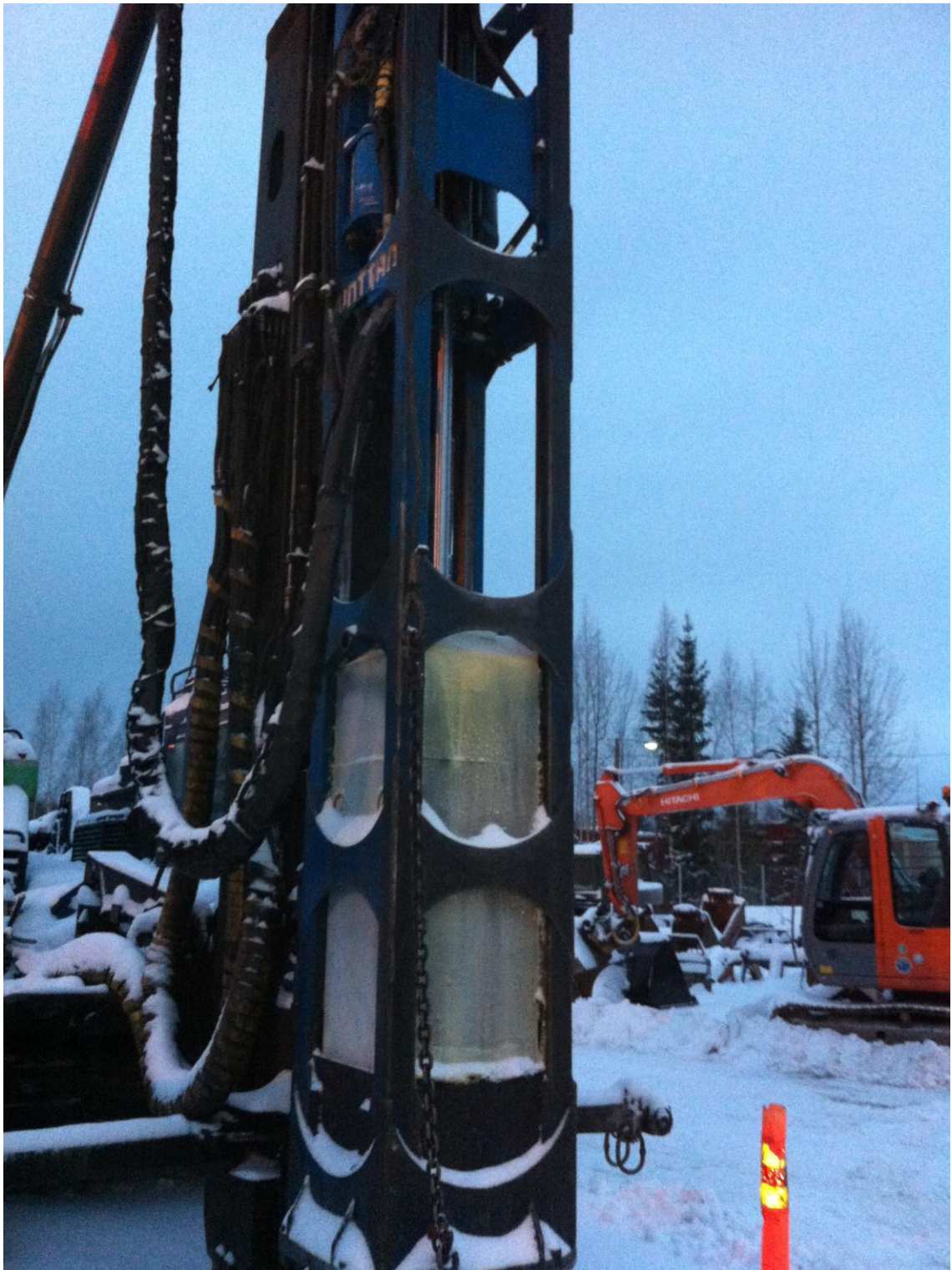
KUVA2. Junttan HHK-sarjan hydraulijärkele. (Henri Unkila)
