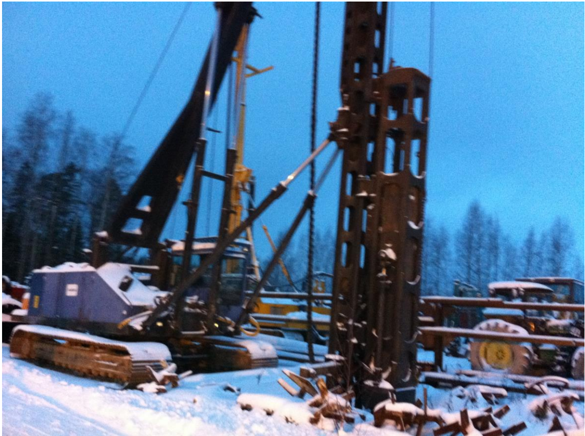
KUVA1. Skanska Infran Junttan PM23 -lyöntipaalutuskone. (Henri Unkila)
