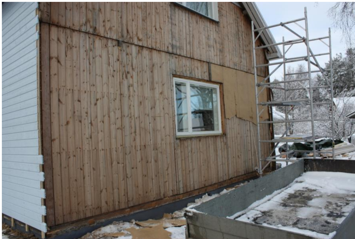
Kuva 44. Umpilaudoitukseen asti purettu ulkoseinä.
