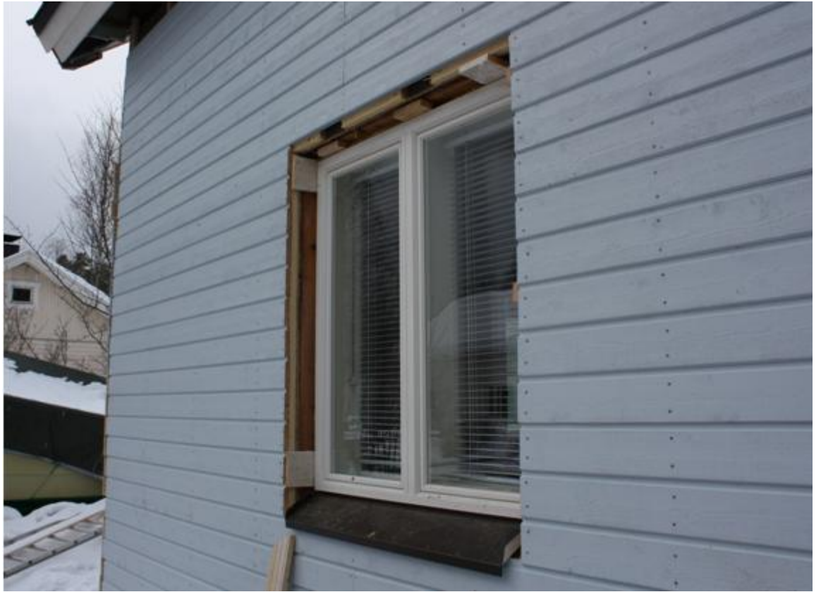
Kuva 54. Smyygin korotuspalat ikkunan vasemmassa reunassa.
