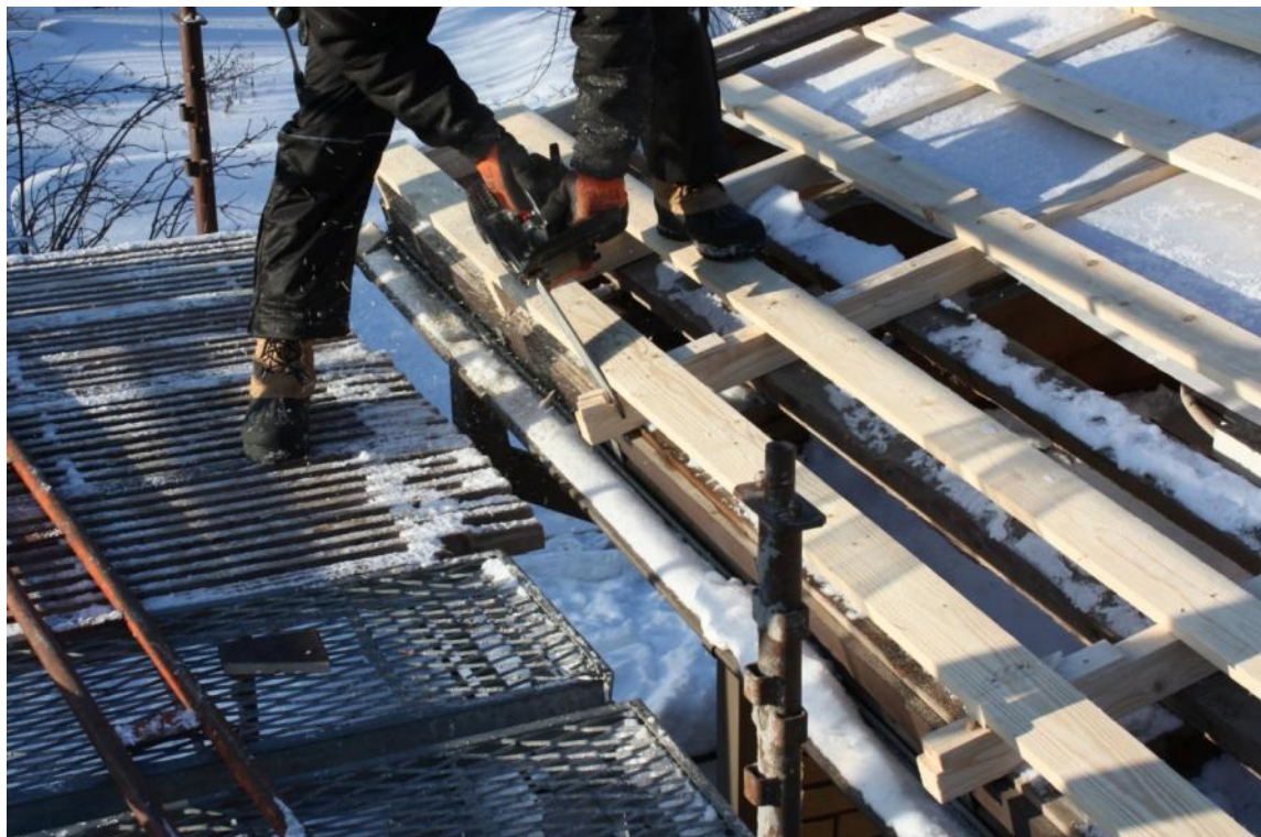
Kuva 21. Koroke- ja tuuletusrimojen sahaus otsalaudan tasalta.
