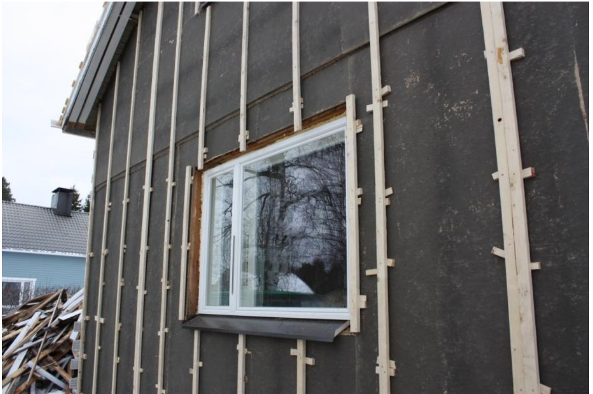
Kuva 49. Tuuletusrimat ja niiden suoristus kiiloilla.
