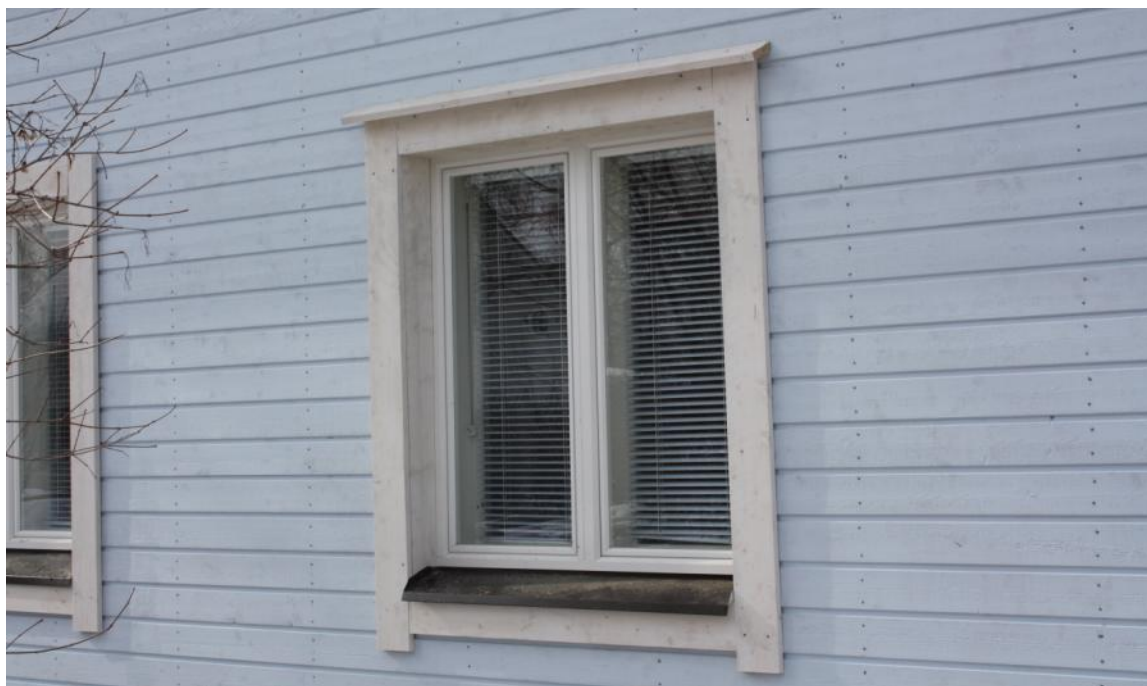
Kuva 55. Valmis ikkunan kehyslaudoitus.
