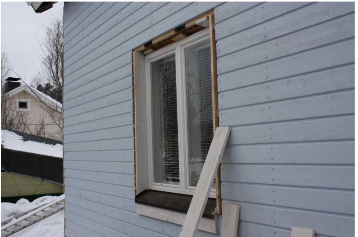
Kuva 54. Sivujen smyygit ja alareunan vuorilauta on kiinnitetty.
