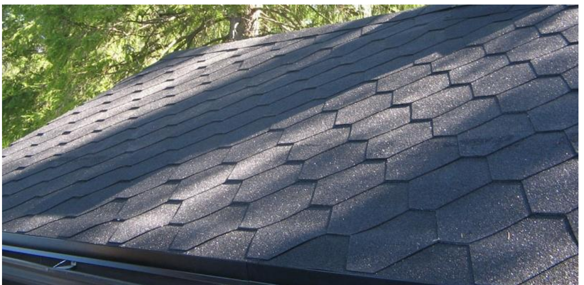
Kuva 7. Bitumikattolaatta- eli palahuopakate. [17.]
