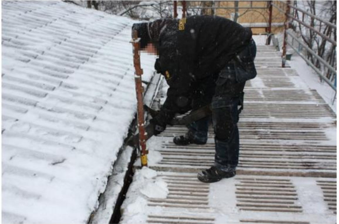
Kuva 12. Räystäslislojen irrotus.
