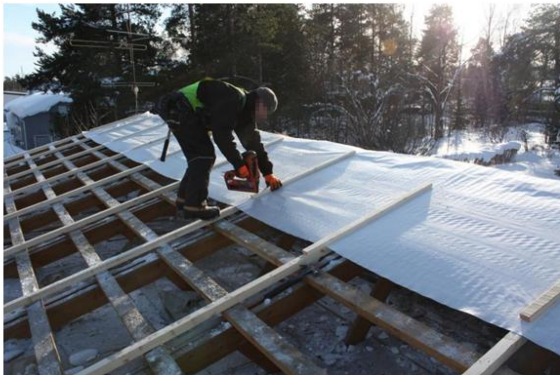
Kuva 17. Tuuletusrimojen kiinnitys.
