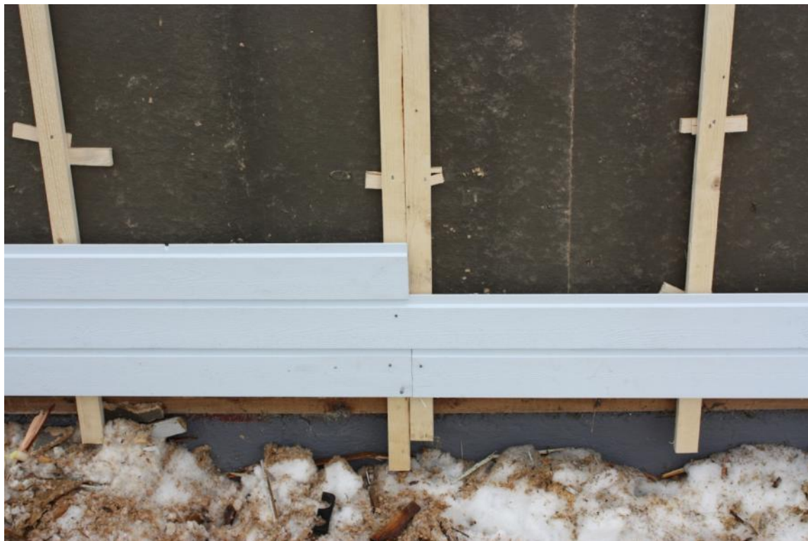
Kuva 50. Paneelien päätysaumat vaakapaneloinnissa.
