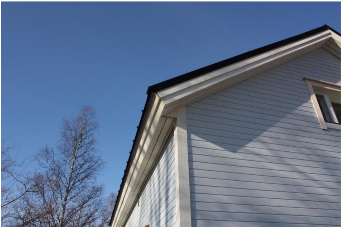
Kuva 52. Räystään aluslaudoitus ja nurkkalaudat.
