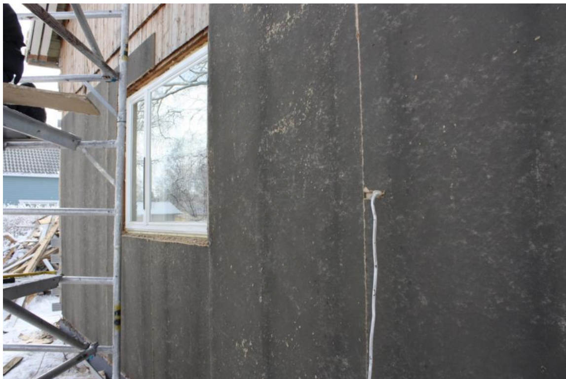
Kuva 48. Tuulensuojalevyt ikkunan ja pinnalle tulevan pistokkeen kohdalla.
