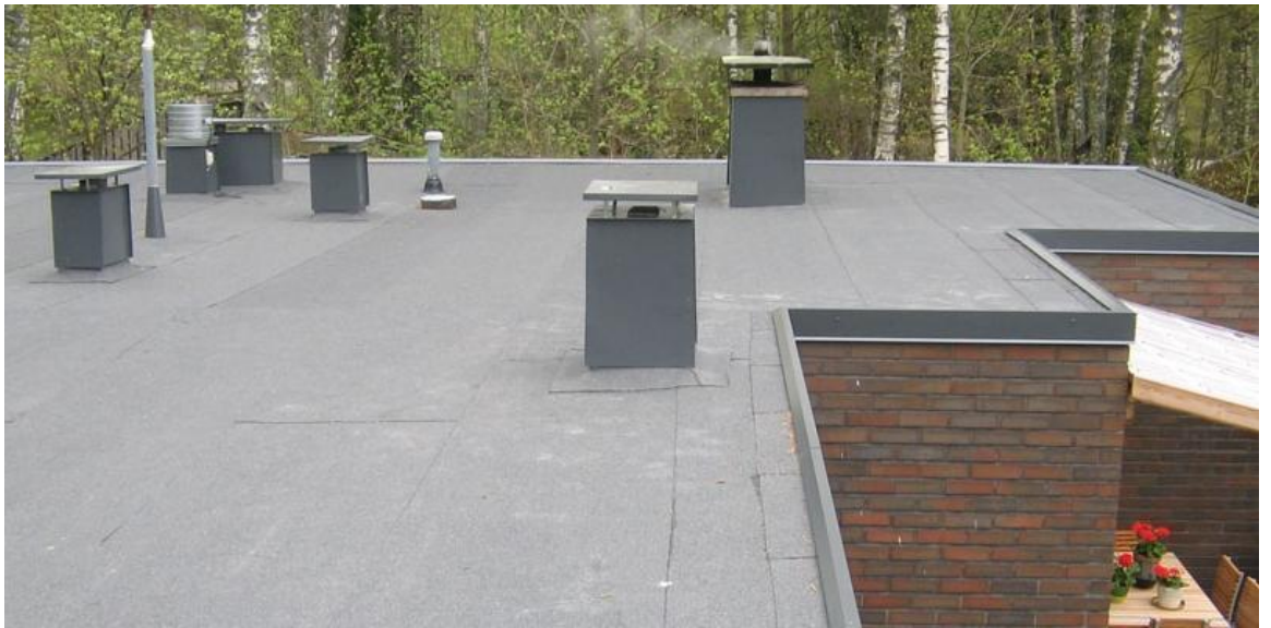
Kuva 6. Tasakaton bitumikermin- eli huopakate. [17.]
