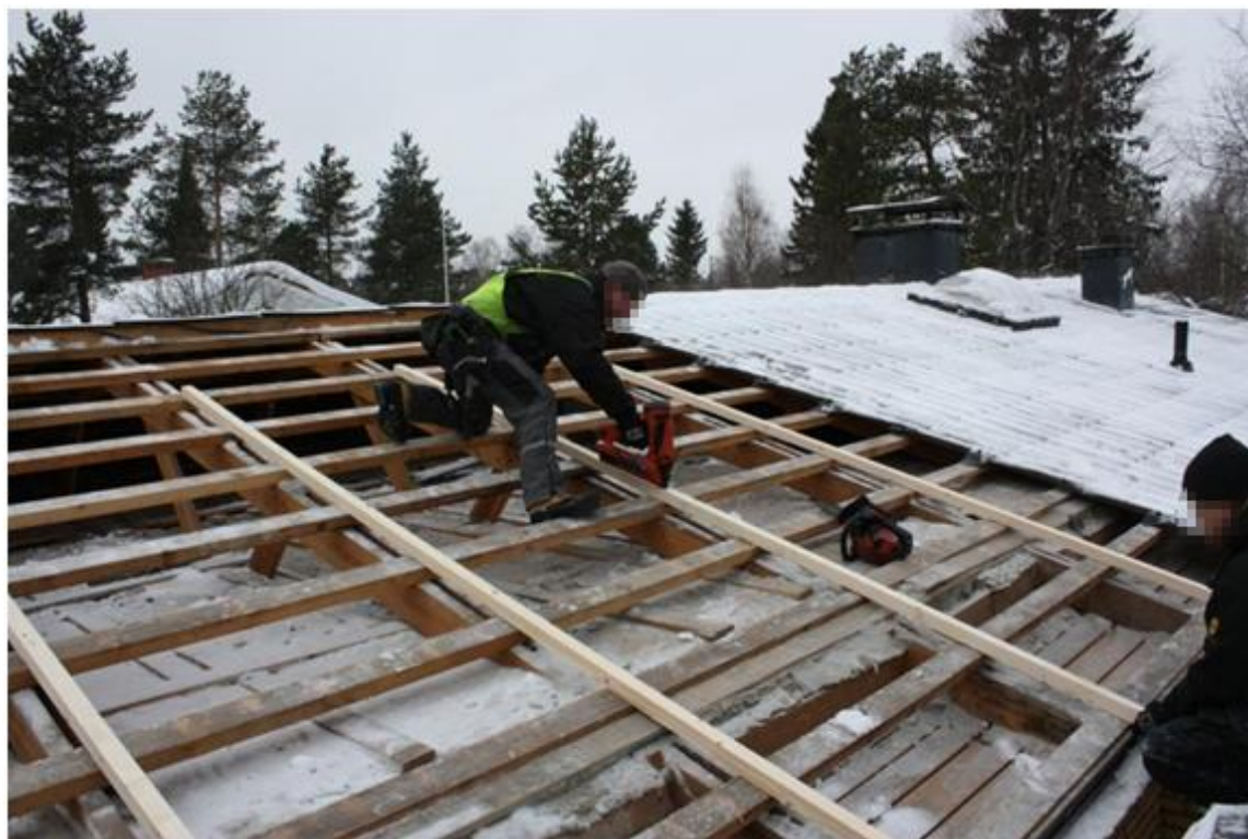
Kuva 13. Korokerimojen kiinnitys vanhoihin ruodelautoihin.
