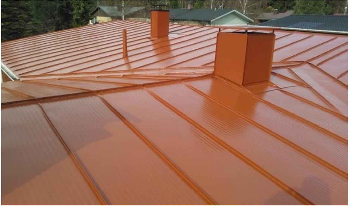
Kuva 2. Konesaumapelti- eli rivipeltikatto. [13.]
