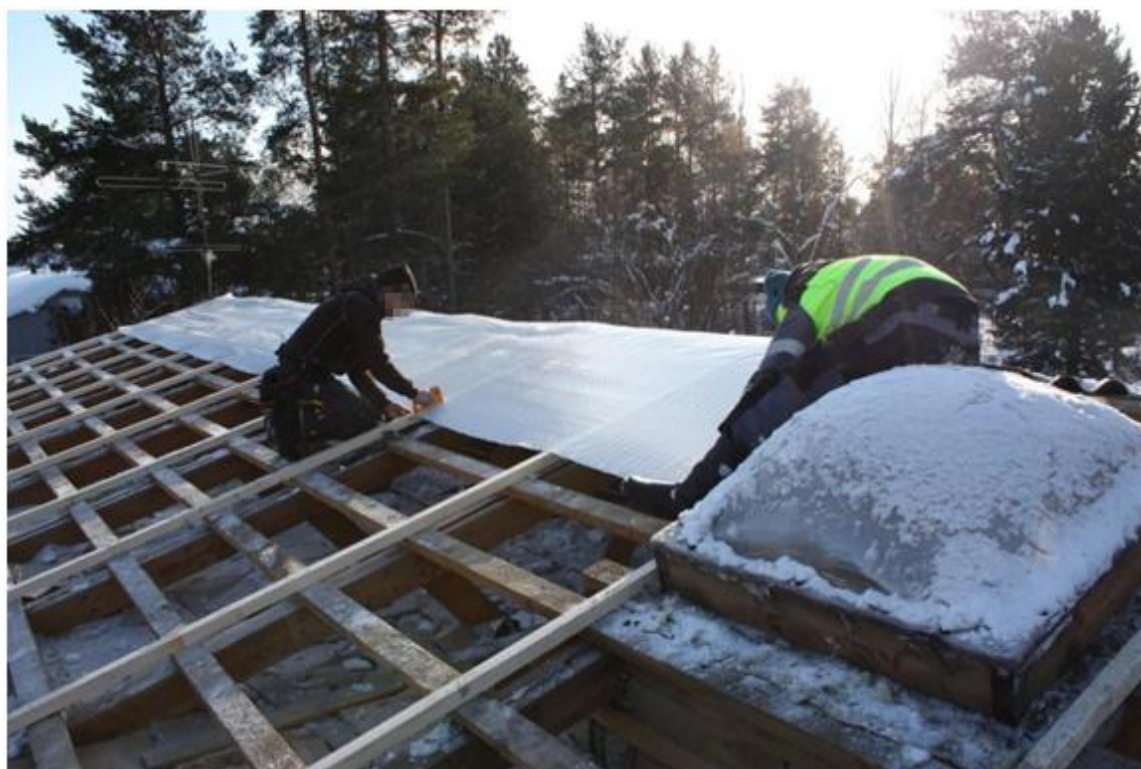
Kuva 15. Aluskatteen kiinnitys korokerimoihin.
