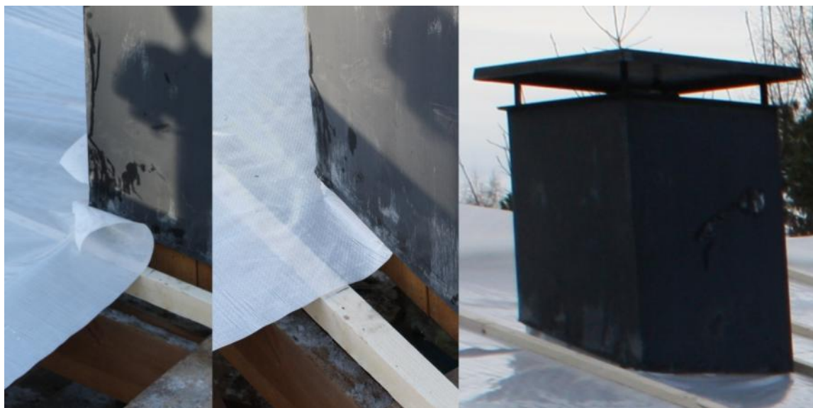
Kuva 16. Aluskatteen asennus pellitetyn läpiviennin kohdalla.
