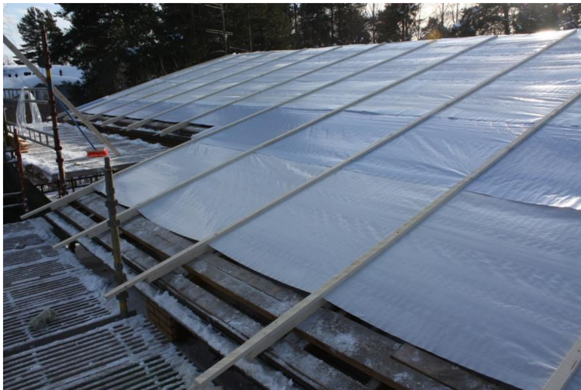
Kuva 18. Aluskate ja tuuletusrimat on kiinnitetty.
