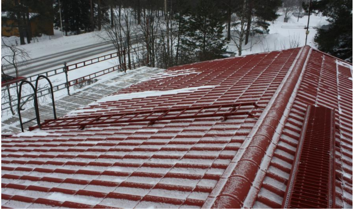
Kuva 34. Turvallinen kulkutie katolla olevalle savupiipulle.
