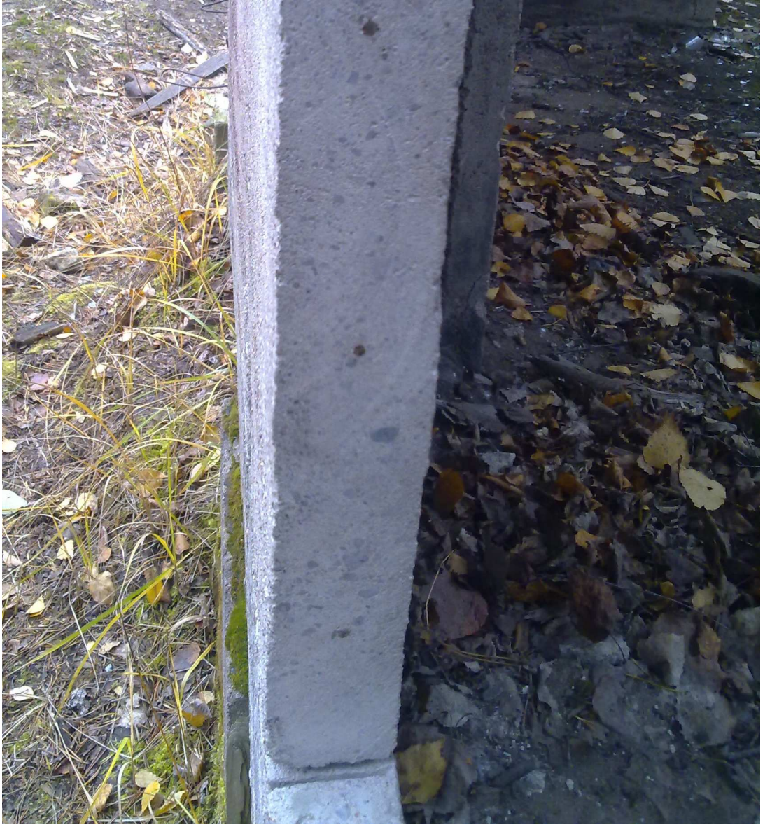
Kuva 8: Raskas seinä (100mm teräsbetoni)
