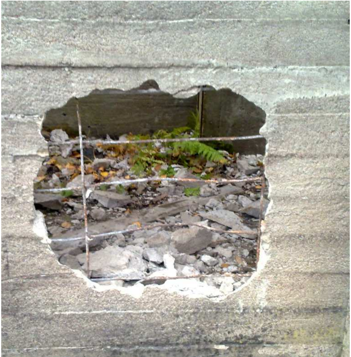
Kuva 9: Raskas seinä (100mm teräsbetoni) työväliseinä leka 5-7kg
