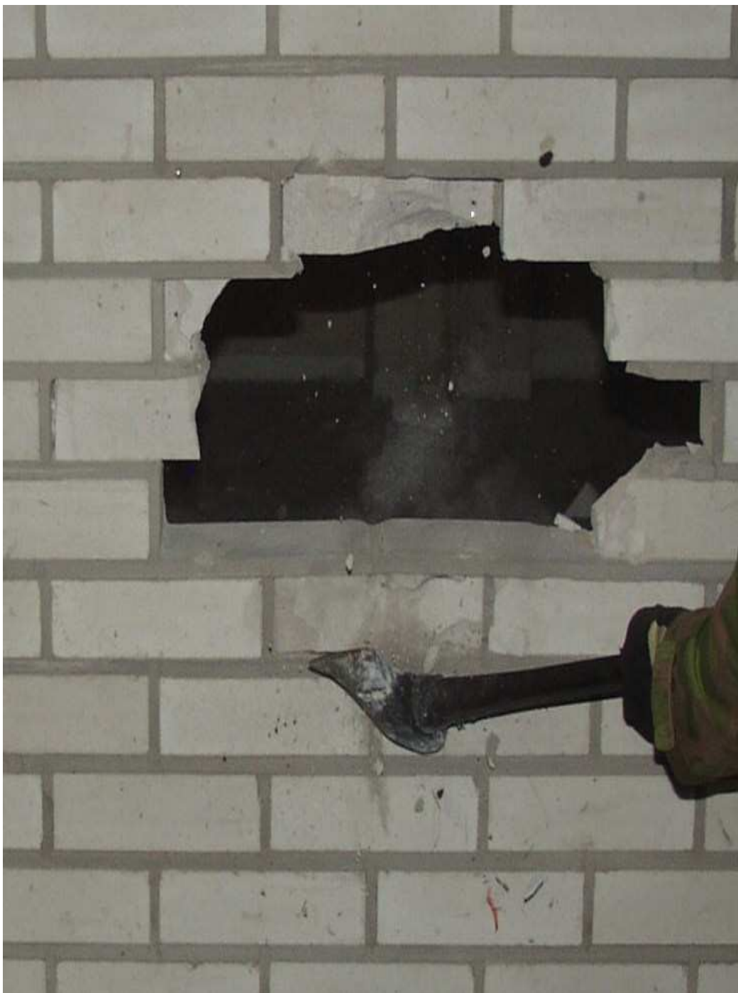
Kuva 7: Aukon tekeminen tiiliseinään kirveellä
