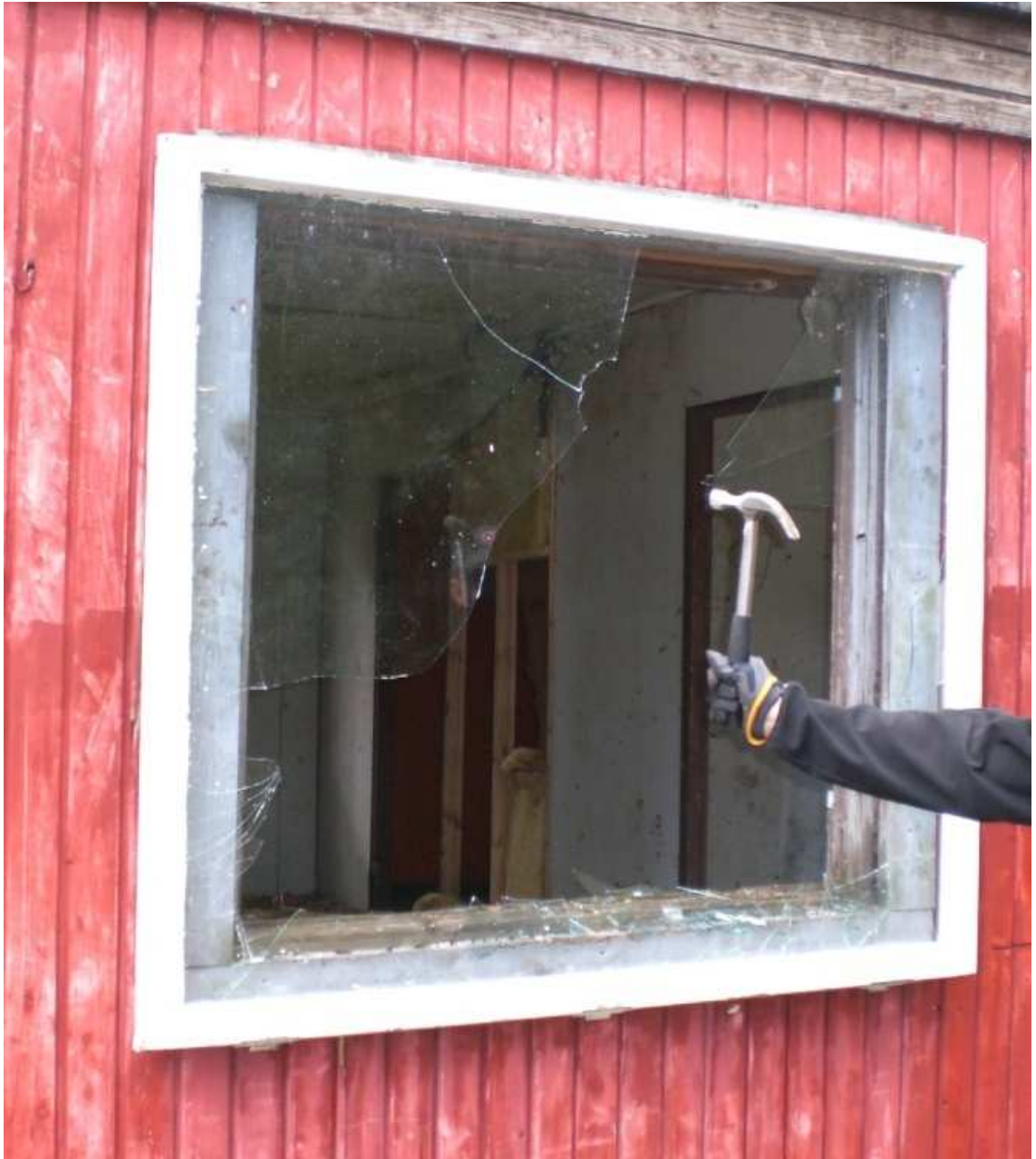
Kuva 15: Yksinkertainen ikkuna vasaralla rikottuna
