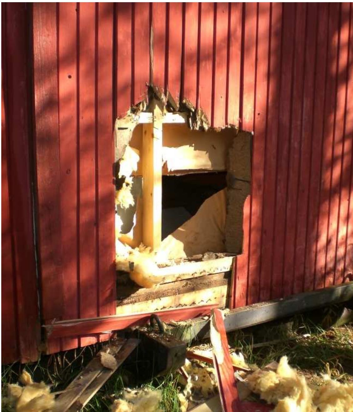
Kuva 6: Kevytrakenteinen rakennuksen ulkoseinä tunkeutuminen kirveellä
