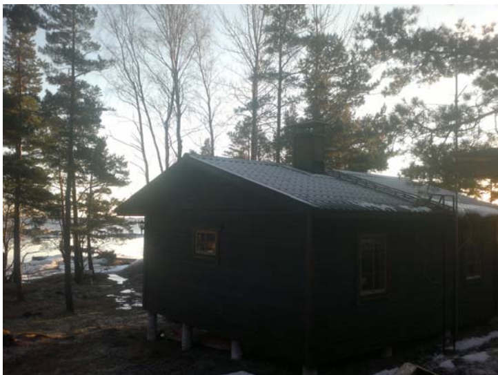
Figur 10. Byggnaden som fungerade som undersökningsobjekt.
