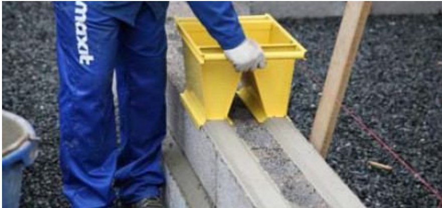
Kuva 3. Harkkojen laastin levitykseen tarkoitettu muurauskelkka
