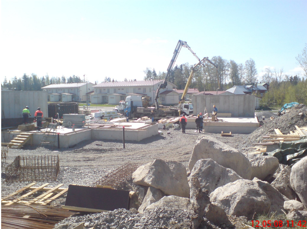
Kuva 13. Viimeisen seinän valu.
