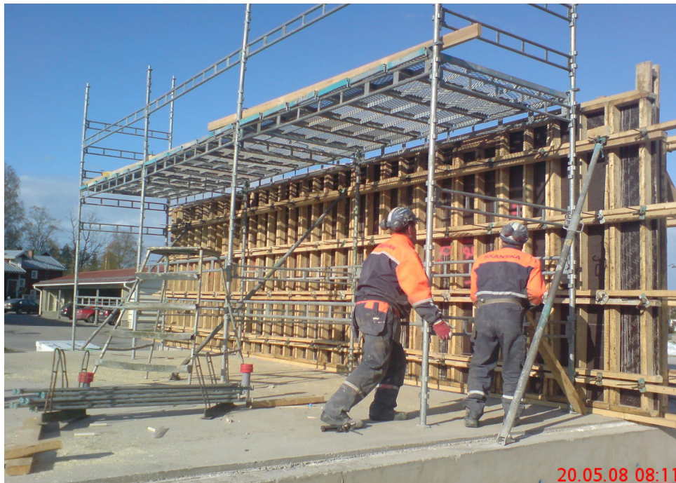
Kuva 6. Kohteessa valmistettujen puumuottien asennus (s.17).
