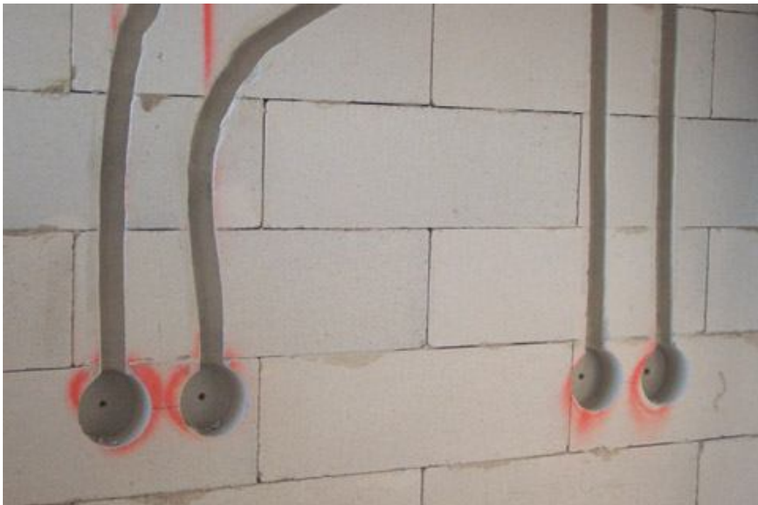
Kuva 5. Sähkörsioiden ja putkien roilotus siporex-seinään.
