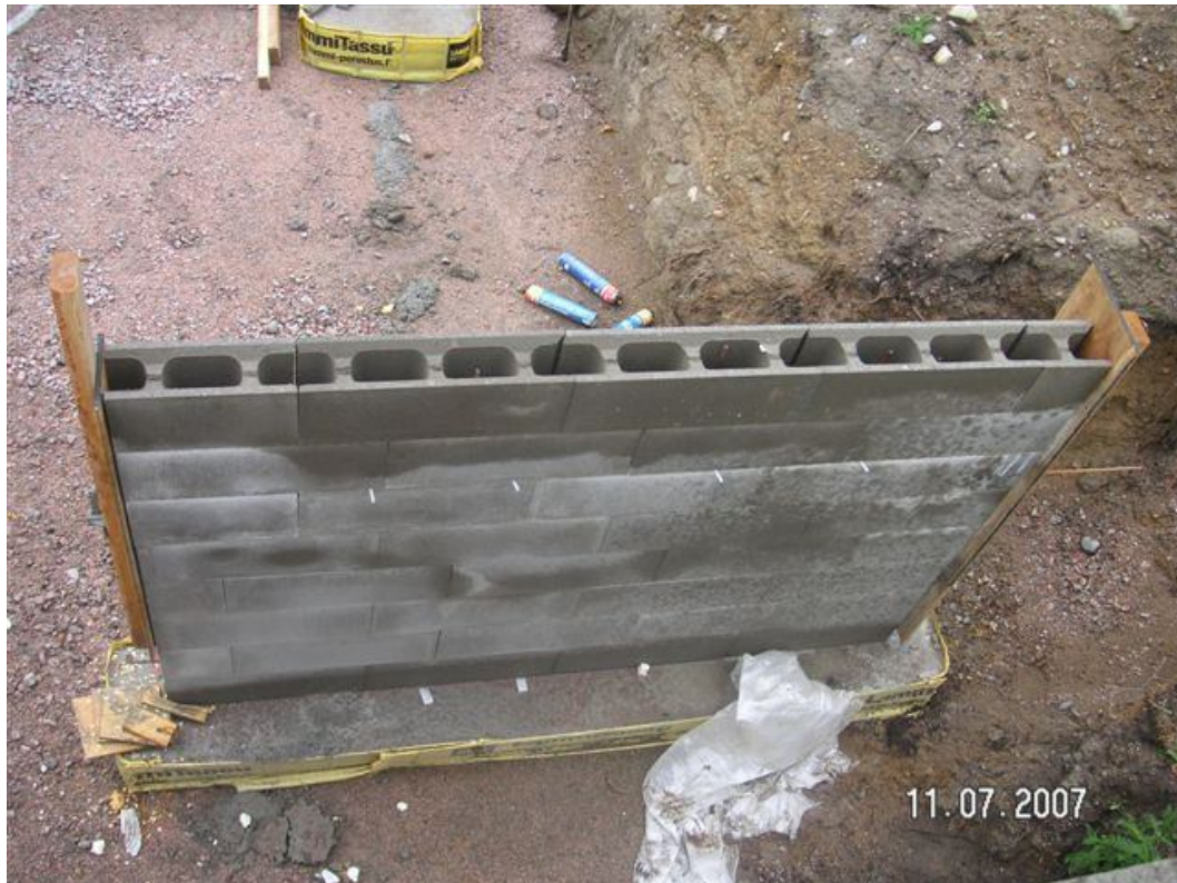
Kuva 2. Valuharkkoseinän päätymuotit.
