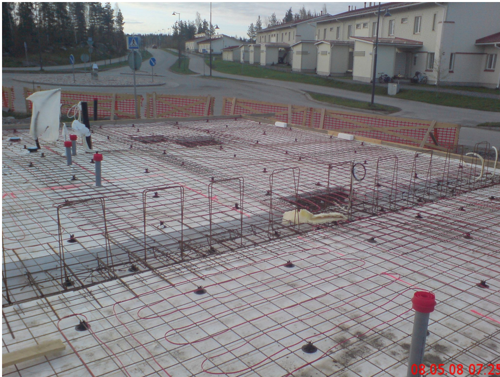
Kuva 1. Paikalla valettavan seinän kiinnitysraudoitukset ja laattavahvikkeen ura.
