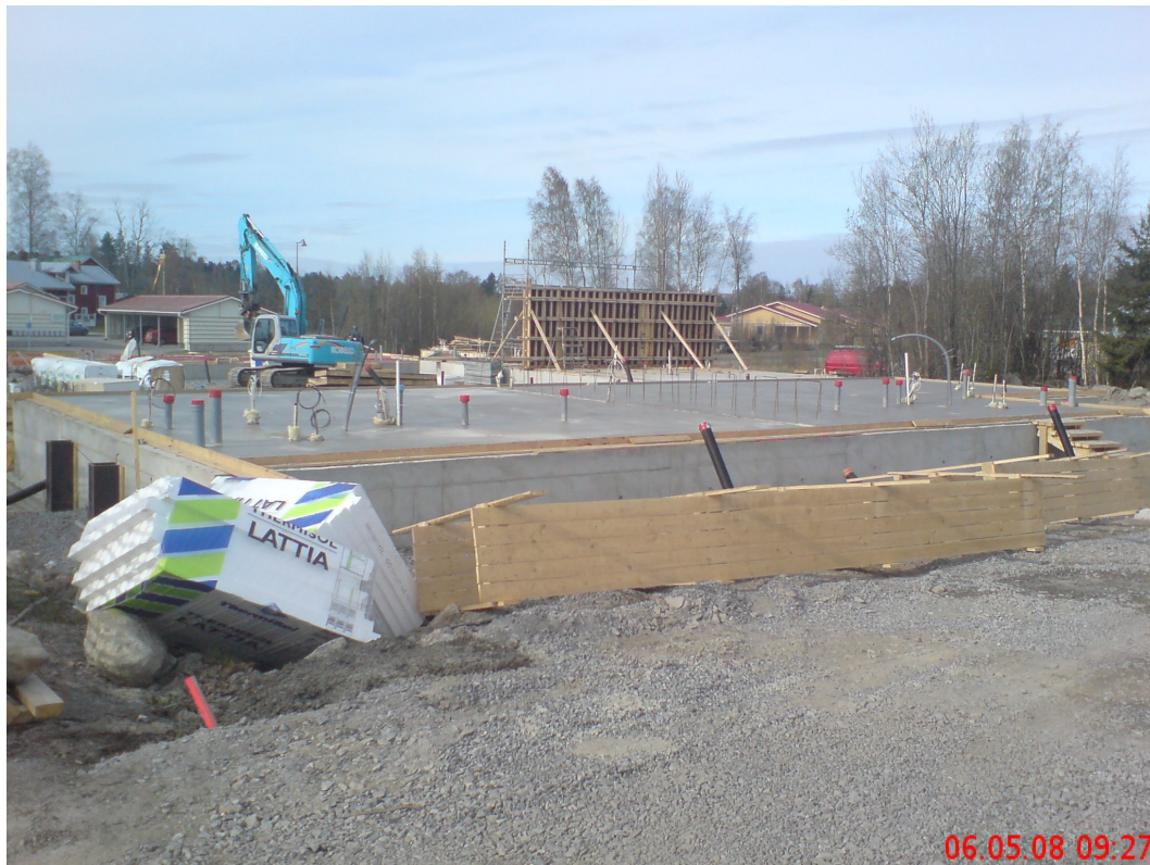
Kuva 12. Ensimmäisen seinän muotit pystytetty (s. 32).
