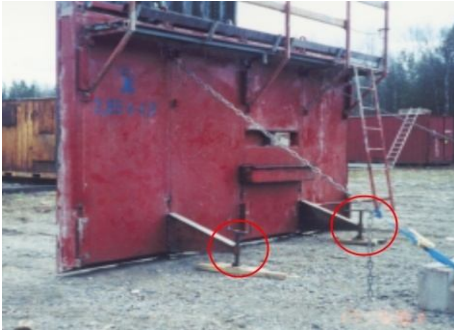
Kuva 10. Suurmuotin tukijalkojen säätöruuvit.
