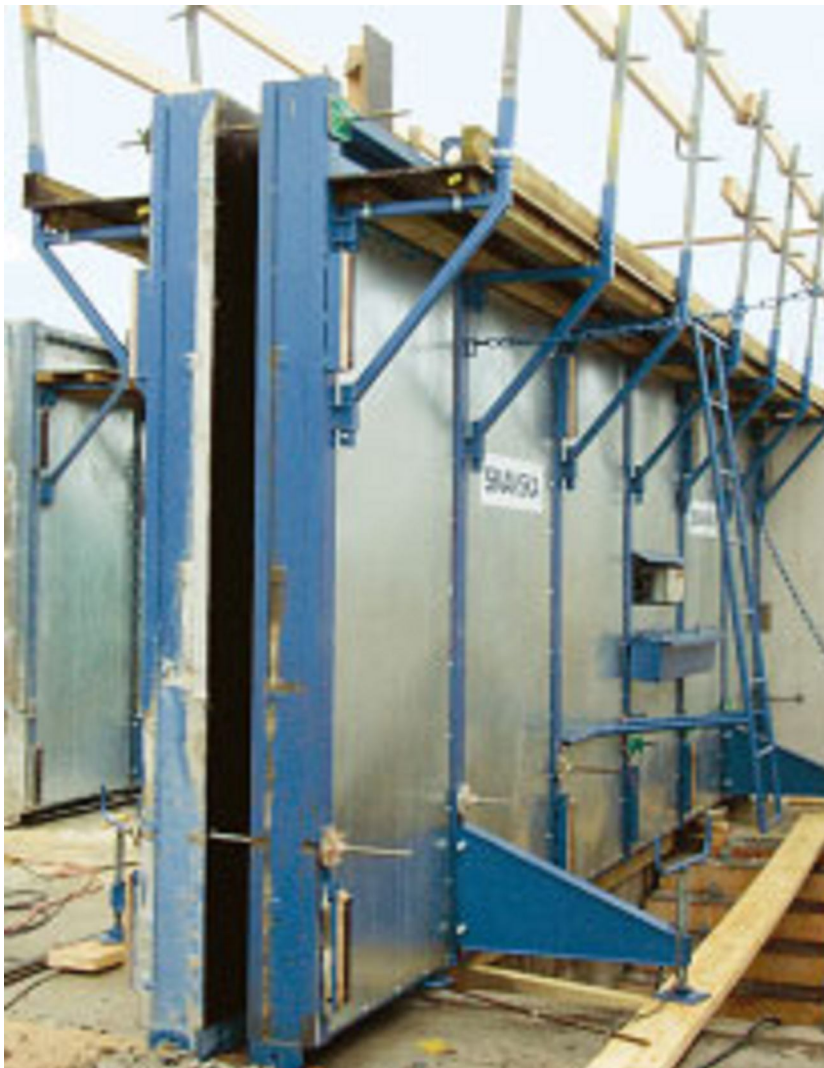
Kuva 9. Skanska Rakennuskoneen suurmuottikalustoa. Muoteissa on kiinteä lämmitysjärjestelmä.
