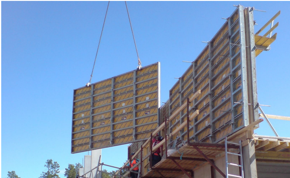
Kuva 7. Järjestelmämuottien asennusta.
