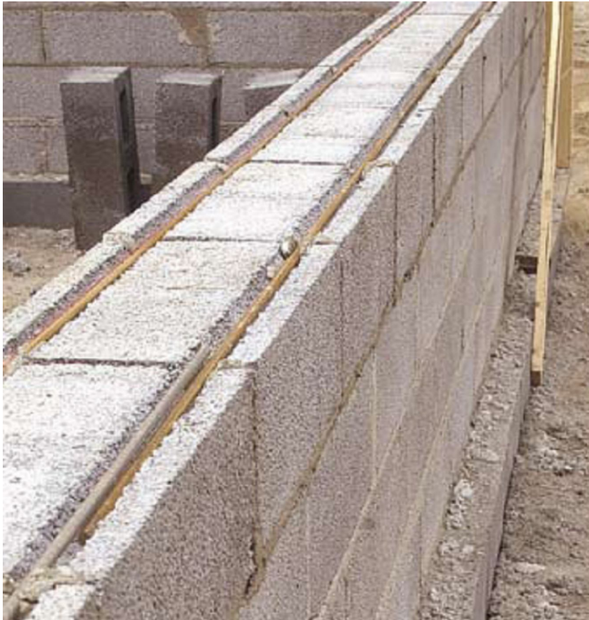
Kuva 4. Esimerkki raudoituksen asentamisesta leca-harkkoon.
