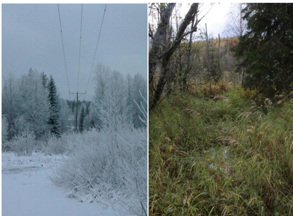
KUVIO 20. Sähkölinja ylittää Kotipuron. Oja sähkölinjan alla
