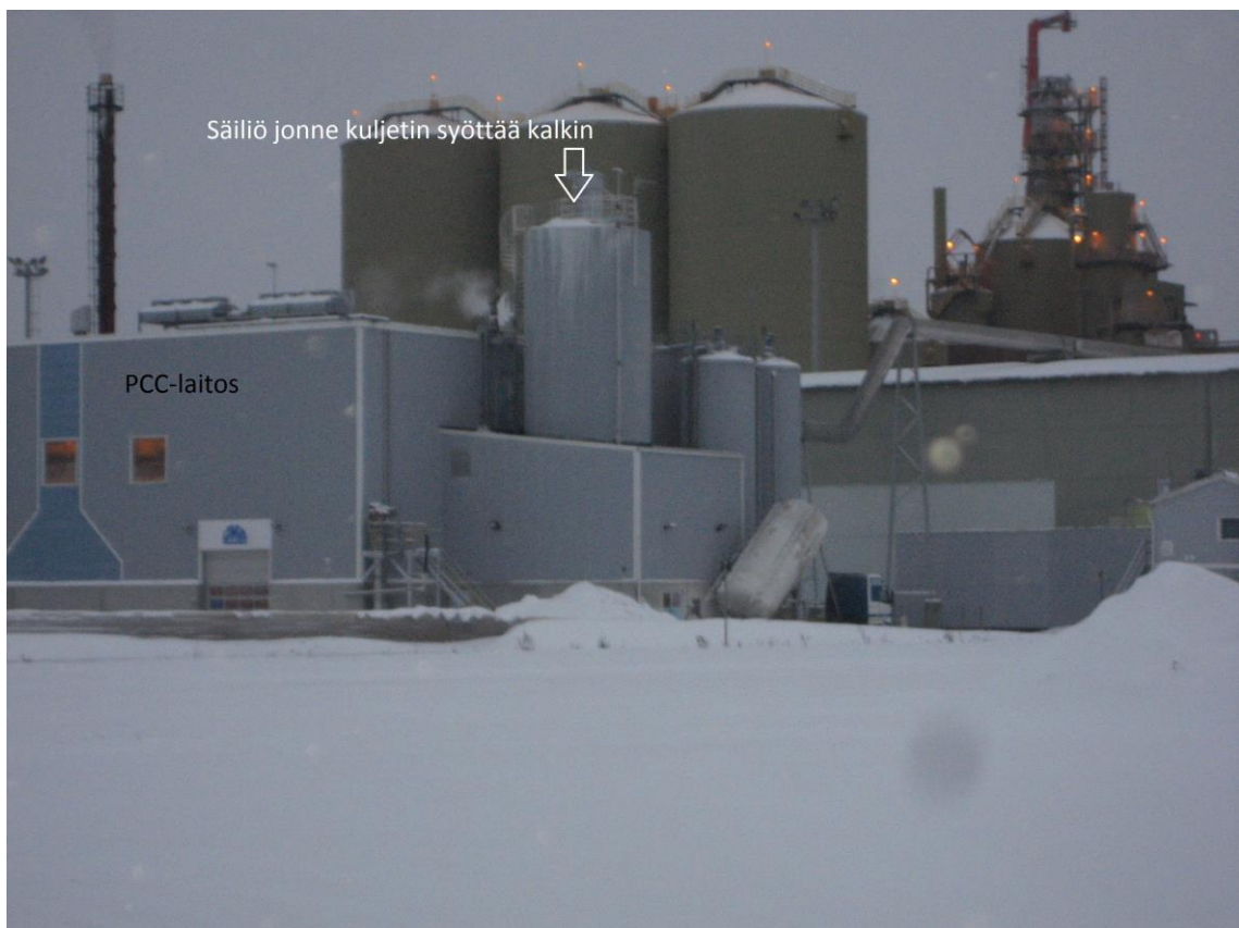
Kuva 13. PCC-laitos ja kalkkisiilo
